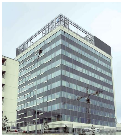
3 pav. Tyrimo objektas – biurų pastatas Vilniuje, Viršuliškių skg. 26
