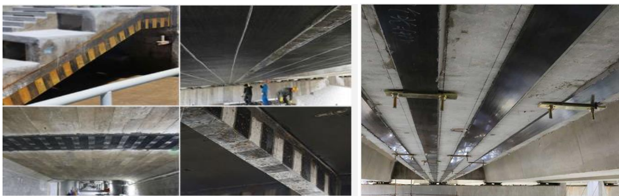
17 pav. Anglies pluošto polimerinės juostos panaudojimas konstrukcijų stiprinimui.
