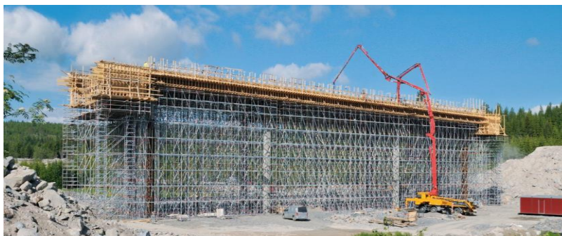
1 pav. Tilto betonavimo darbuose naudojama atraminių pastolių sistema
