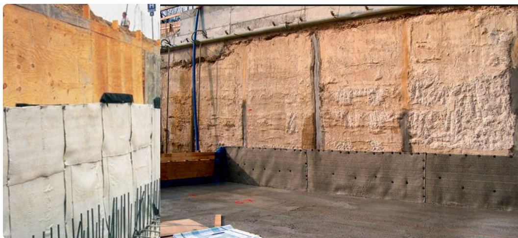
4 pav. Bentonitinio molio membranų sistema
