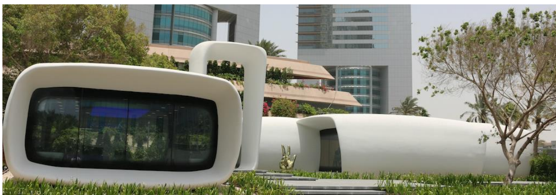
4 pav. Pirmasis pilnai funkcionuojantis ofisas Dubajuje, atspausdintas 3D spausdintuvu.
