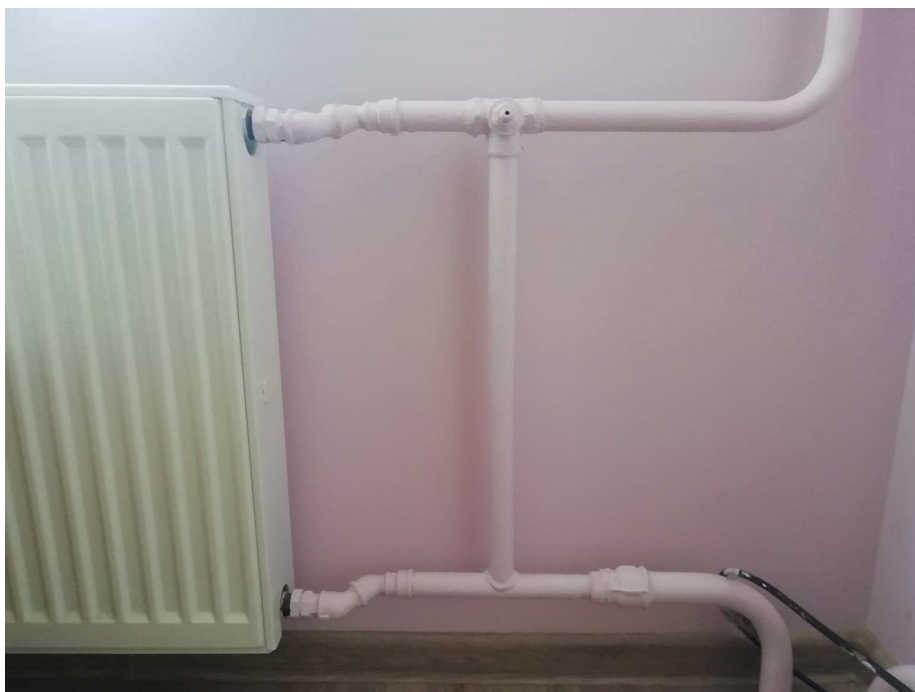
6.1 pav. Dabartinis tipinio radiatoriaus pajungimas
