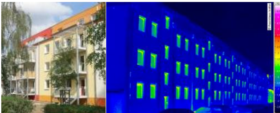
3 pav. Pastato nuotrauka (kairėje) ir termografinis pastato vaizdas (dešinėje) po atnaujinimo [7].
