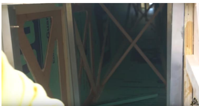
10 pav. Apatinės dalies mazgų sujungimas skersinėmis atramomis su priešingos pusės viršutinės dalies mazgais [41]
