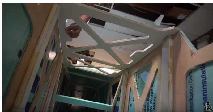
5 pav. Po viršutine dalimi paklijuoti ferminės konstrukcijos elementai jungimui tarp šoninių dalių [40]
