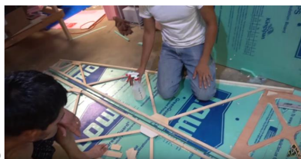
2 pav. a) Ferminės konstrukcijos jungimas jungiamąja plokštele. b) Sujungti serminės konstrukcijos mazgai [40]
