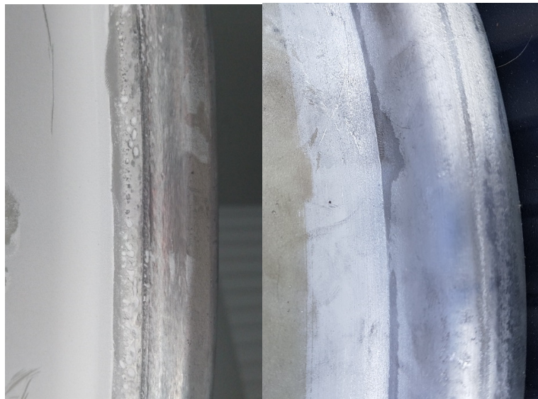
5.1 pav. Detalė prieš padengimą (kairėje) ir po padengimo (dešinėje)
