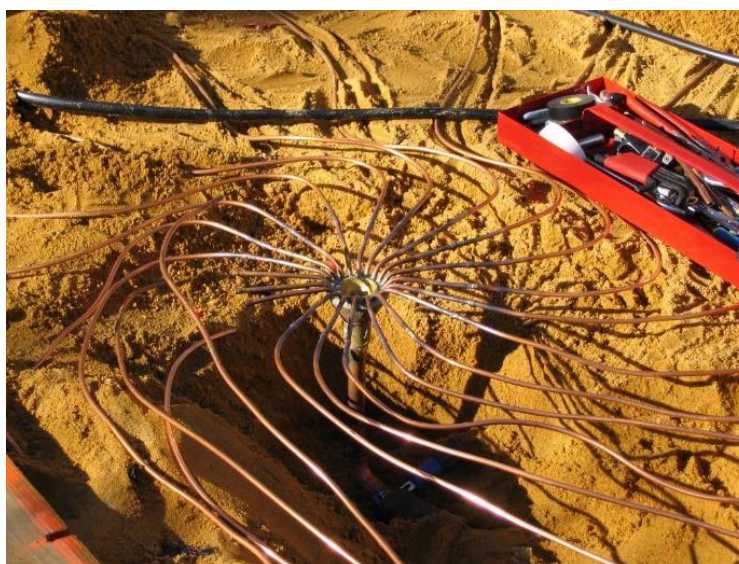
4.3 pav. Tiesioginio išgarinimo grunto kolektorius [17]
