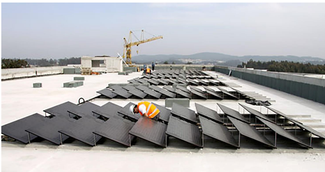
2.9 pav. Termodinaminio saulės šilumos siurblio plokščių montavimo pavyzdys
