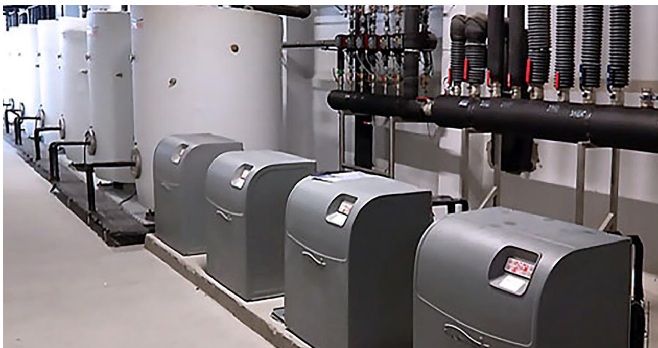
2.11 pav. Termodinaminių saulės šilumos siurblių ir akumuliacinių talpų sugrupuotos sistemos pavyzdys
