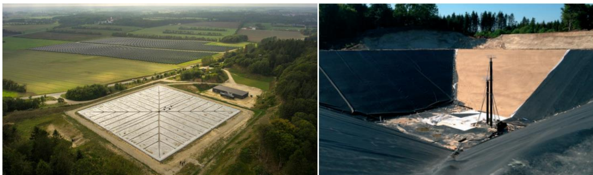
3.3 pav. PIT tipo šilumos akumuliacinės talpyklos pavyzdys
