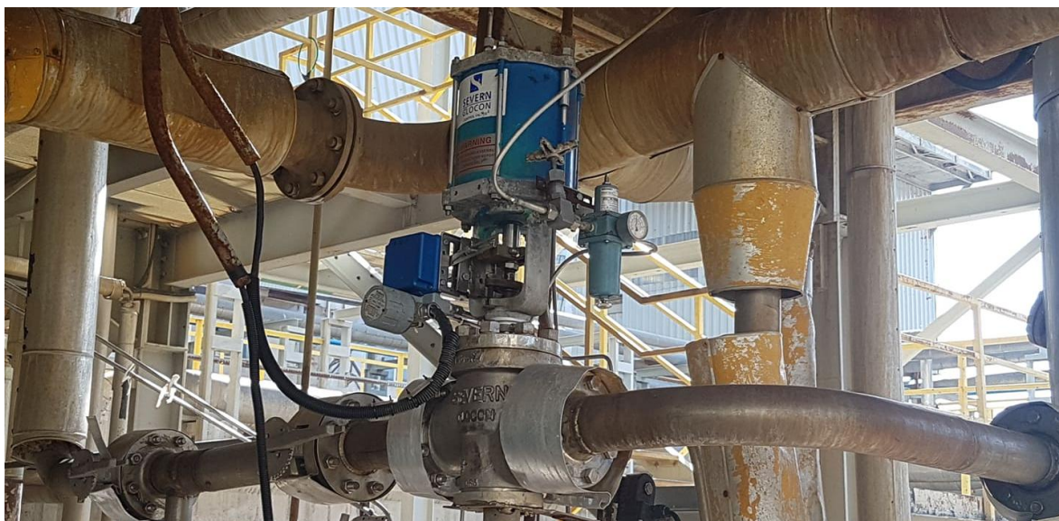
11 pav. Azoto rūgšties srautą reguliuojantis vožtuvas.
