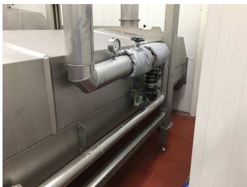
1.5 pav. Pasterizavimo įrenginys, garo padavimo mazgas
