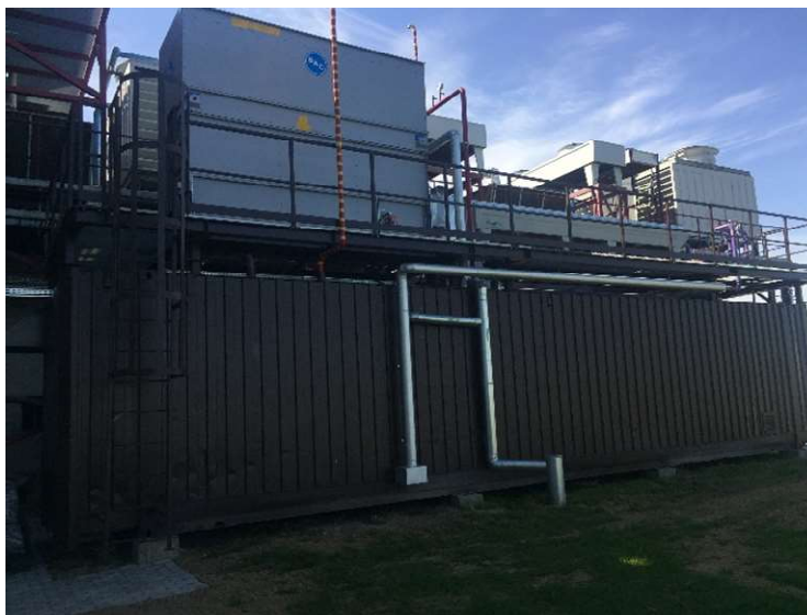
1.16 pav. Kompresoriaus konteineris su pagalbinais aušinimo įrenginiais
