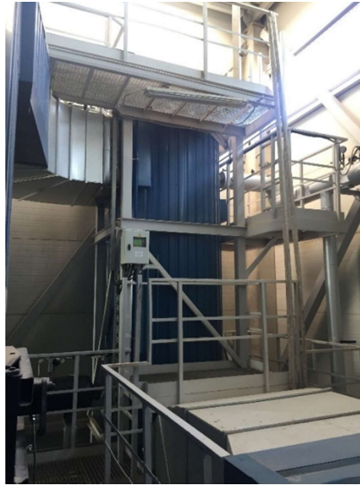
1.17 pav. Biokuro katilinės sausasis ekonomaizeris
