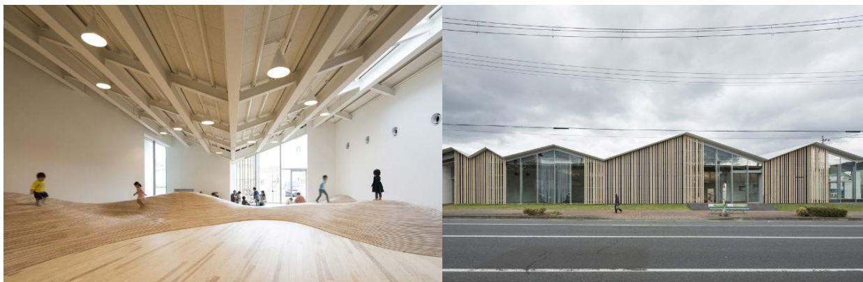
5 pav. „Towada community plaza“ bendruomenės centro fasadas, interjero erdvės. [šaltinis] http://kkaa.co.jp/works/architecture/towada-city-plaza/
