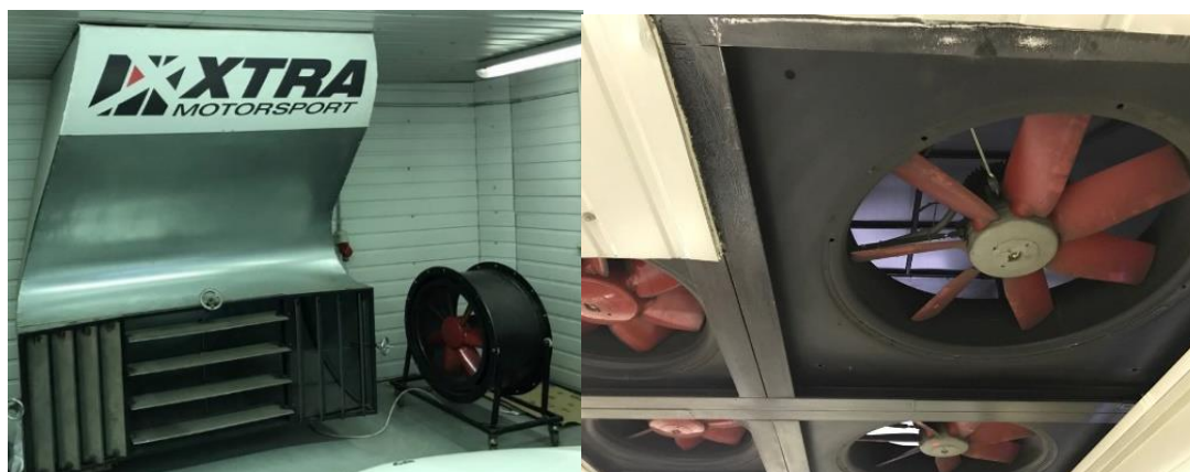
2.18 pav. Pūtimo ir ištraukimo ventiliatoriai
