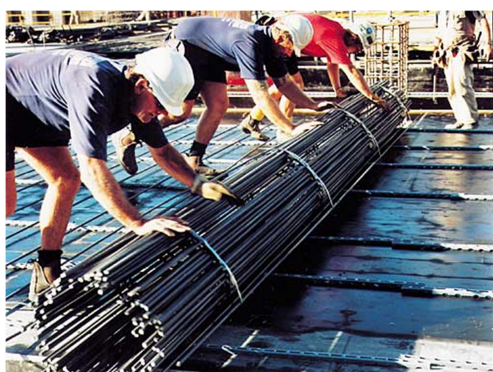
1.11 pav. „Bamtec“ armatūros įrengimas.
