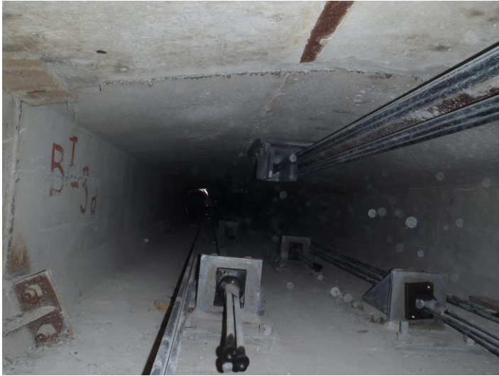
18 pav. Įtemptosios armatūros išdėstymas (Babų viadukas)
