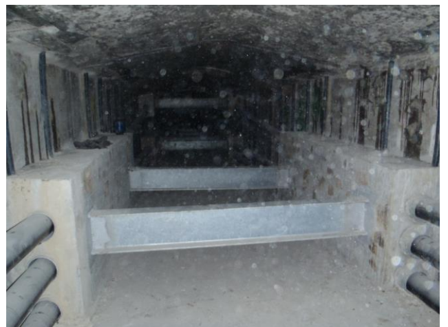
19 pav. Įtemptosios armatūros išdėstymas (Nemenčinės viadukas)
