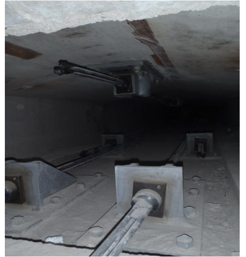
18 pav. Įtemptosios armatūros išdėstymas (Babų viadukas)
