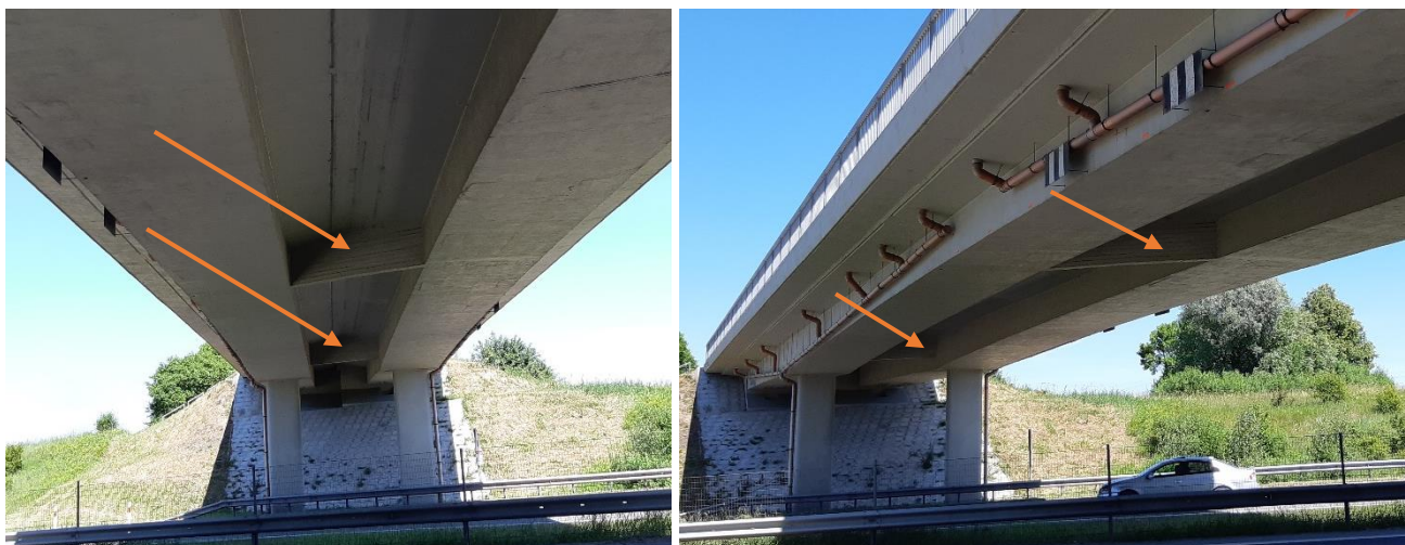
24 pav. Skersinės sijos, jungiančios dėžines sijas tarpusavyje
