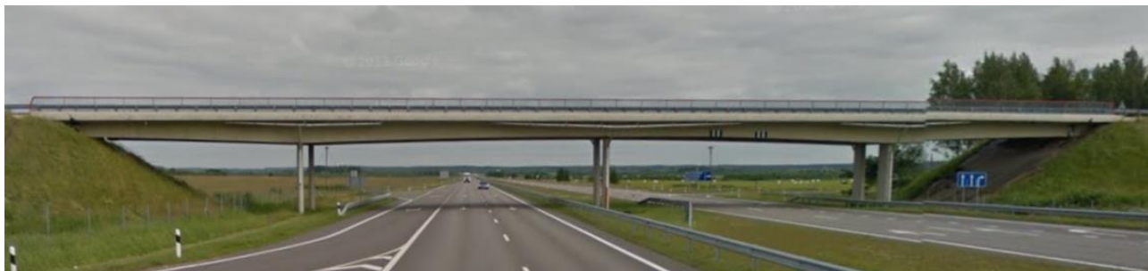
48 pav. Viadukas, sustiprintas įrengus tarpines atramas (A2 ir E272 kelių sankirta) [14]
