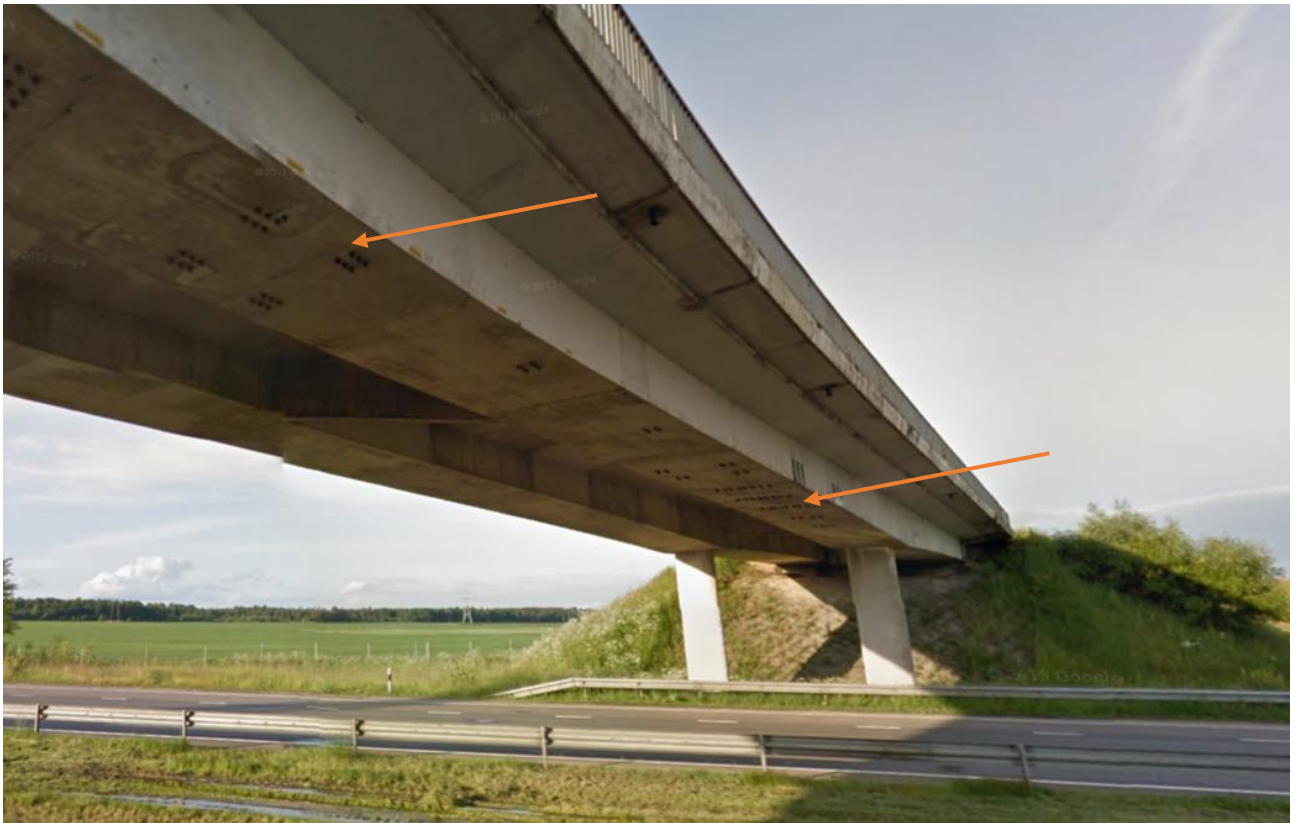
16 pav. Viadukas, kurio tik viena sija sustiprinta (pažymėta rodyklėmis) [16]
