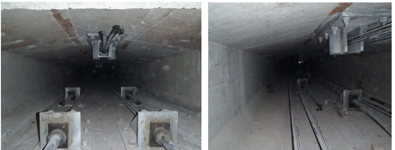
17 pav. Įtemptosios armatūros išdėstymas
