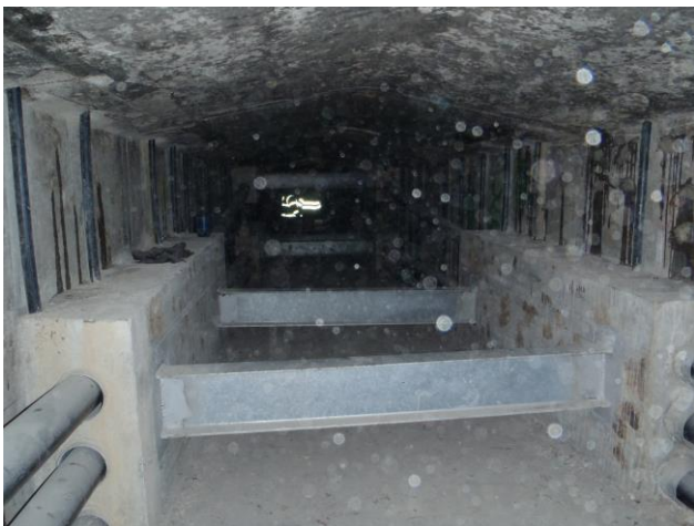
19 pav. Įtemptosios armatūros išdėstymas (Nemenčinės viadukas)
