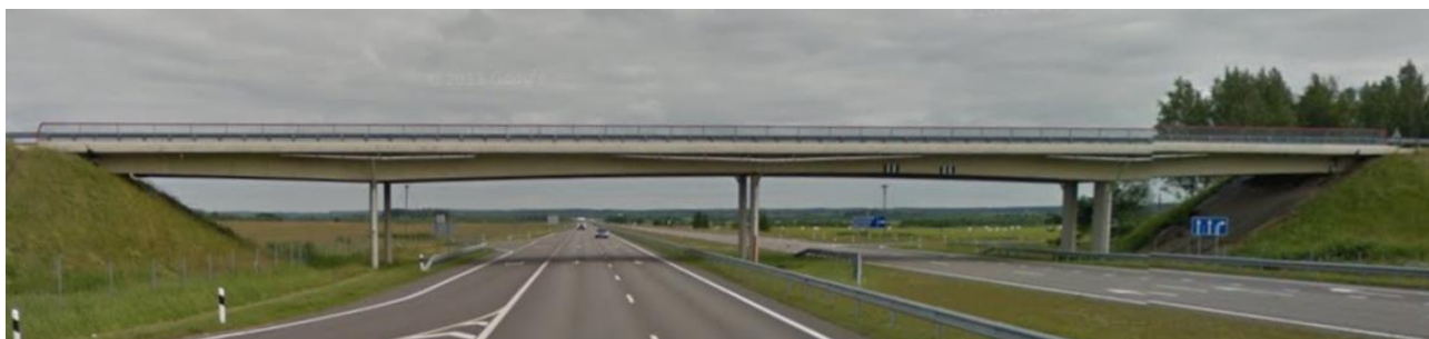
15 pav. Viadukas, sustiprintas įrengus tarpinės atramas (A2 ir E272 kelių sankirta) [15]
