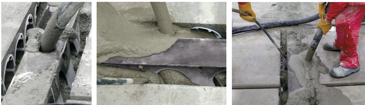
19 pav. „Deltabeam“ sijos betonavimas [6]
