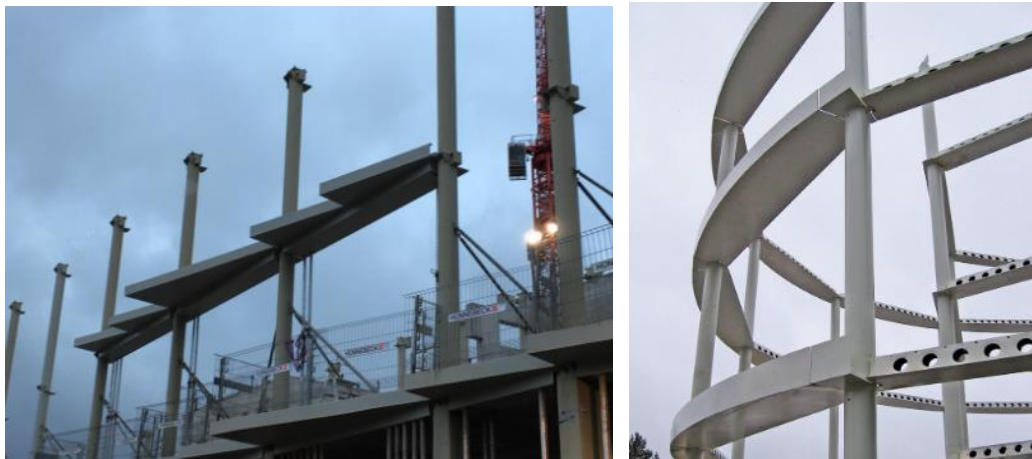
81 pav. Išankstiniai klojiniai, naudojami su kompozitinėmis sijomis [3]
