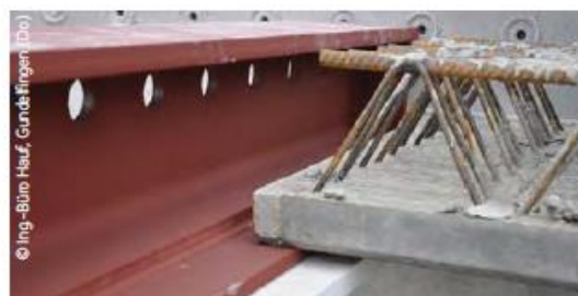
23 pav. „Slimfloor beam“ kompozitinės sijos skerspjūvis bei pritaikymas [7]
