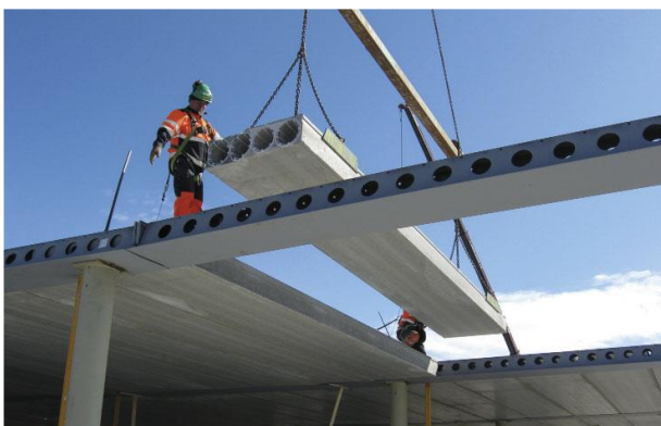
16 pav. Kiaurymėtų perdangų plokščių montavimas [6]
