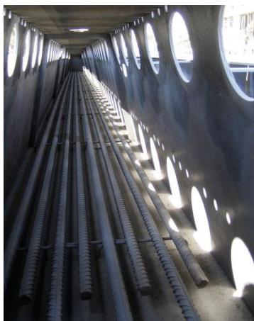
11 pav. Gaisro armatūra „Deltabeam“ sijos viduje [5]
