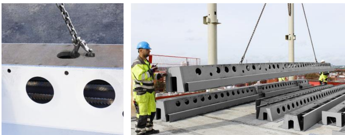
13 pav. „Deltabeam“ sijų kėlimas [6]
