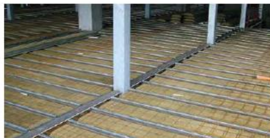
22 pav. „Slimfloor beam“ nekompozitinės sijos skerspjūvis bei pritaikymas [7]
