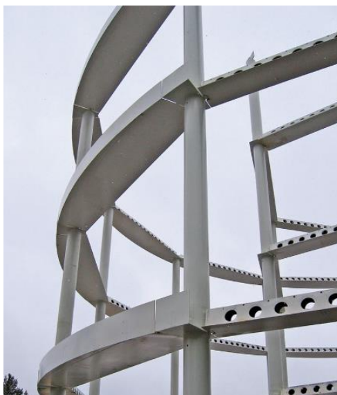
59 pav. „Deltabeam“ sijos su išankstiniais klojiniais [26]
