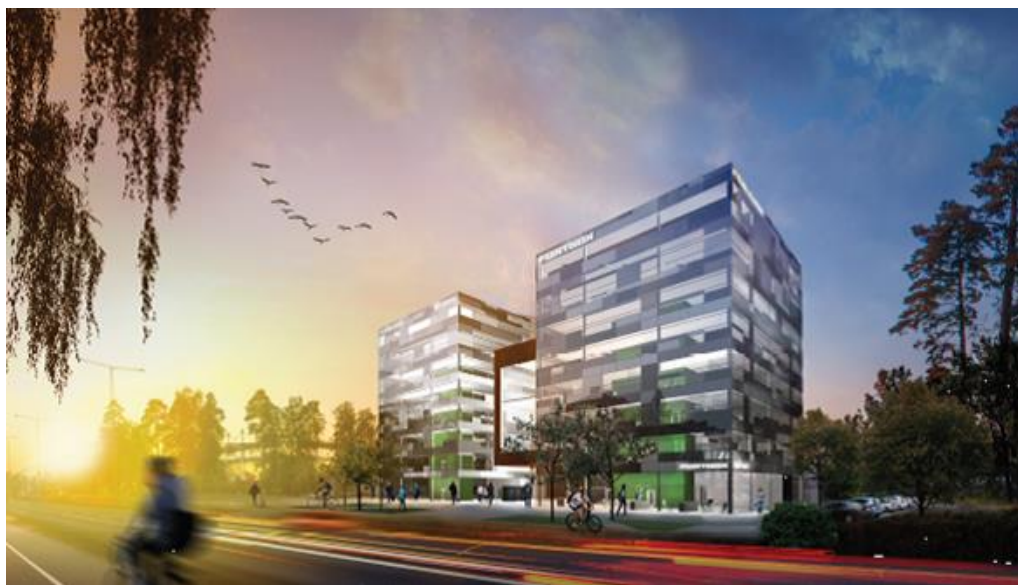
50 pav. „Fortnox“ administracinis pastatas [17]
