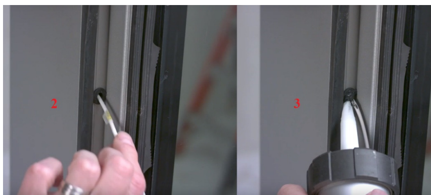
32 pav. Laido išvedimo vieta elektrochrominiui stiklui
