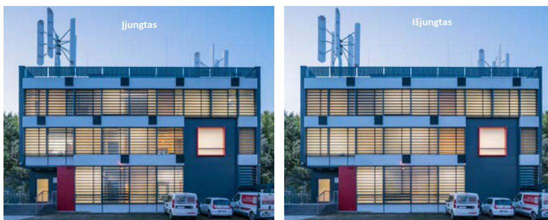
4 pav. Fasadas sudarytas iš elektroniniu būdu valdomu stiklų, kai jis įjungtas ir išjungtas.
