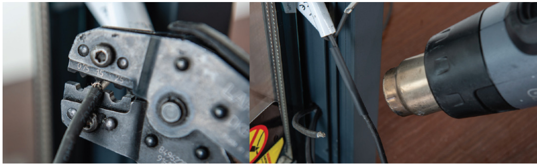
43 pav. Izoliuojami Elektra šildančio stiklo paketo laidai
