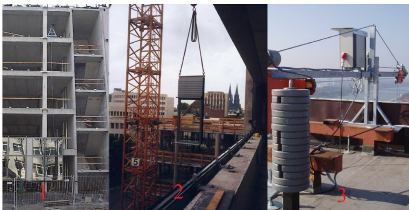
25 pav. 1. Hidraulinis (tarpaukštinis) kranas; 2. bokštinis kranas; 3. stoginis kranas
