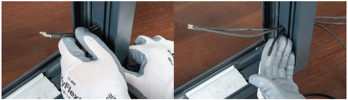
40 pav. Elektra šildančio stiklo paketo laidai praveriamas pro aliuminį profilį
