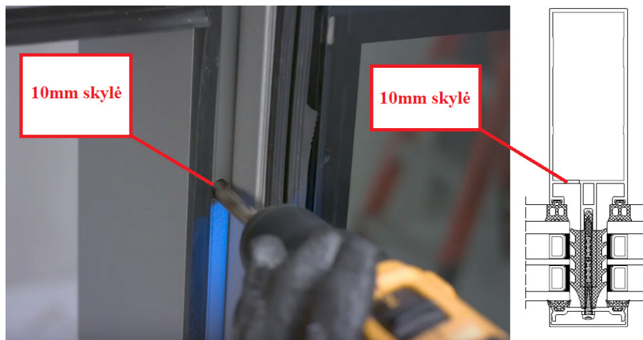
31 pav. Laido išvedimo vieta elektrochrominiui stiklui
