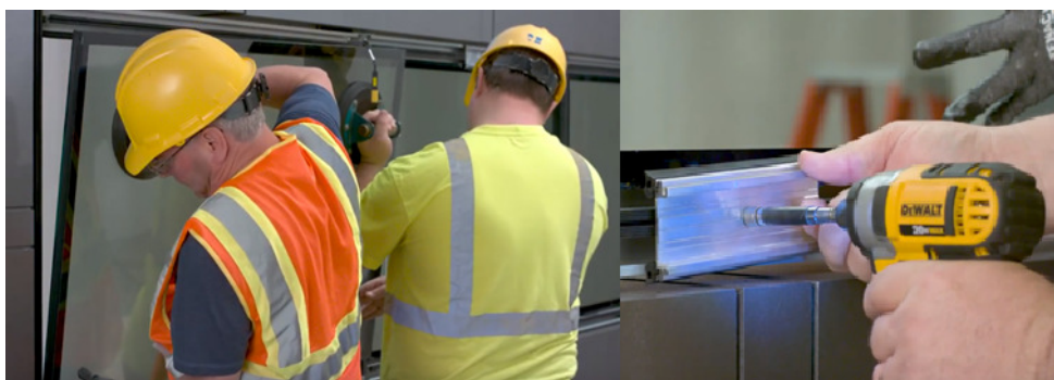
33 pav. Elektrochrominis stiklo paketas įmontuojamas į konstrukciją
