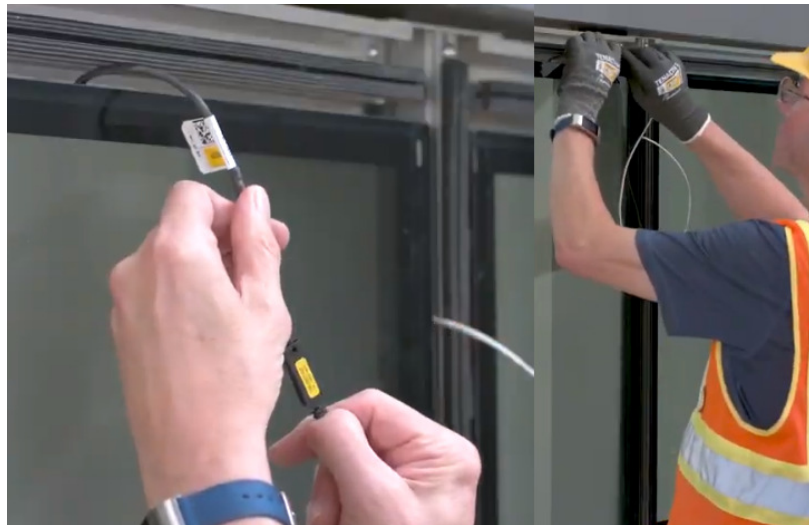
34 pav. Sujungiami elektrochrominio stiklo paketo laidai
