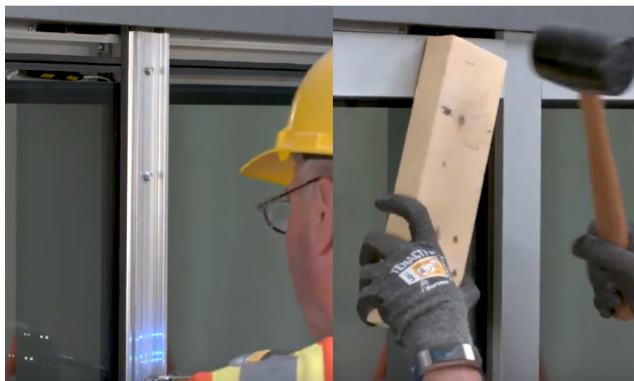
36 pav. susukami stiklo paketo prispaudėjai ir sukalami apdailiniai dangteliai
