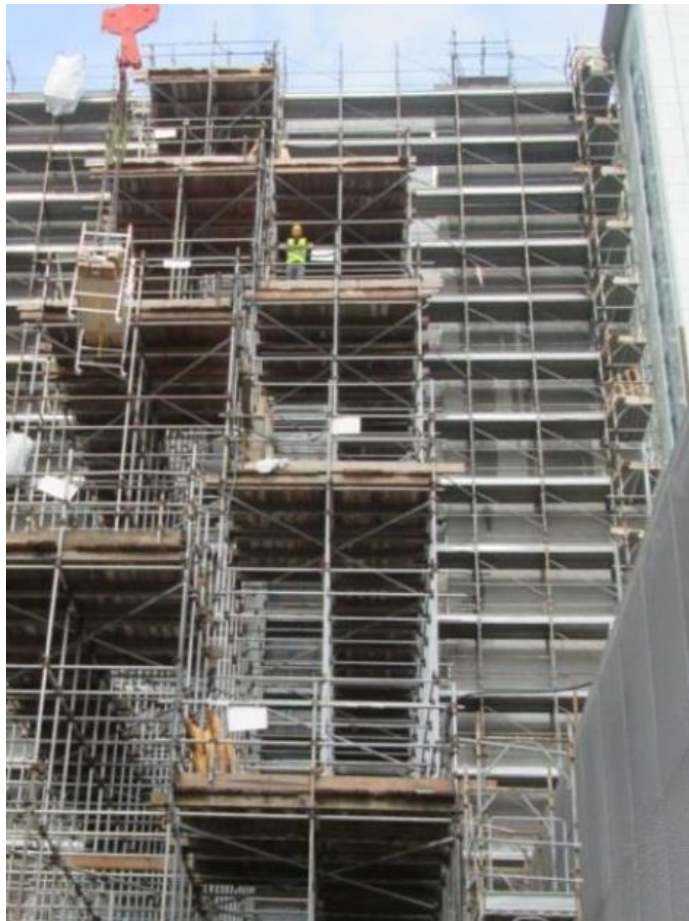
7 pav. Sandėliavimo aikštelės ant pastolių [8]
