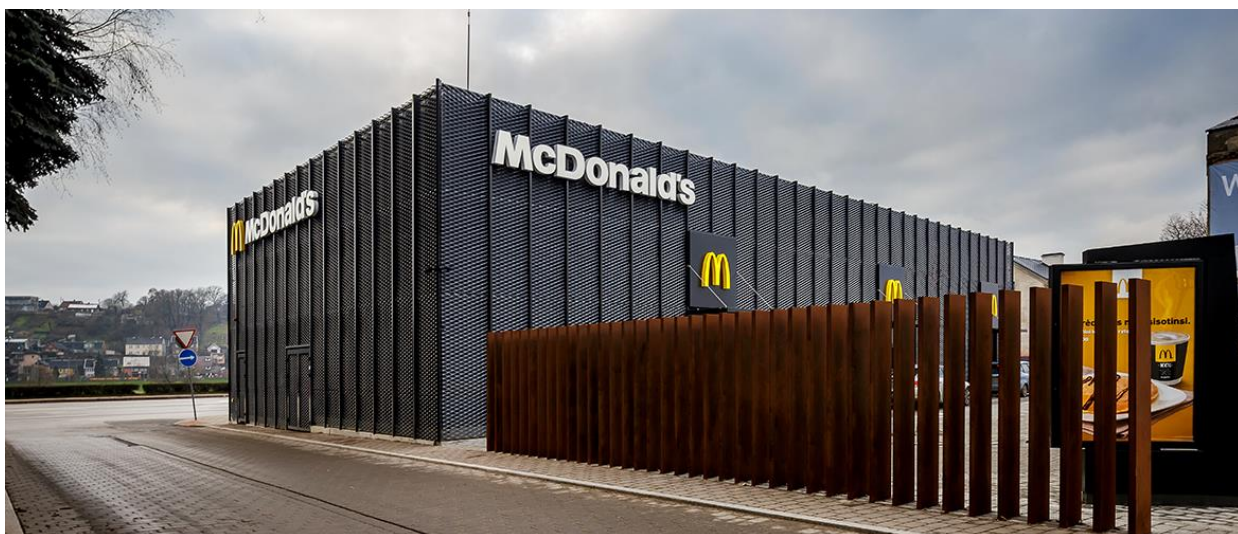
1.14 pav. Fasadas su kirstai tempto metalo lakštais [9]
