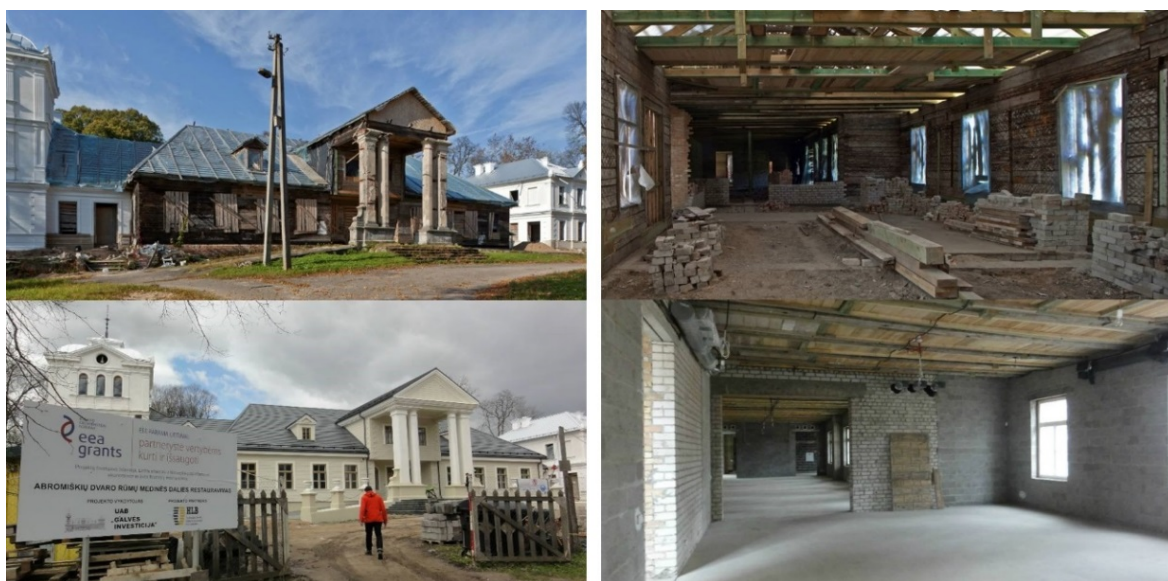
19 pav. Abromiškės dvaro medinių pastatų restauravimo ir atkūrimo darbai.
