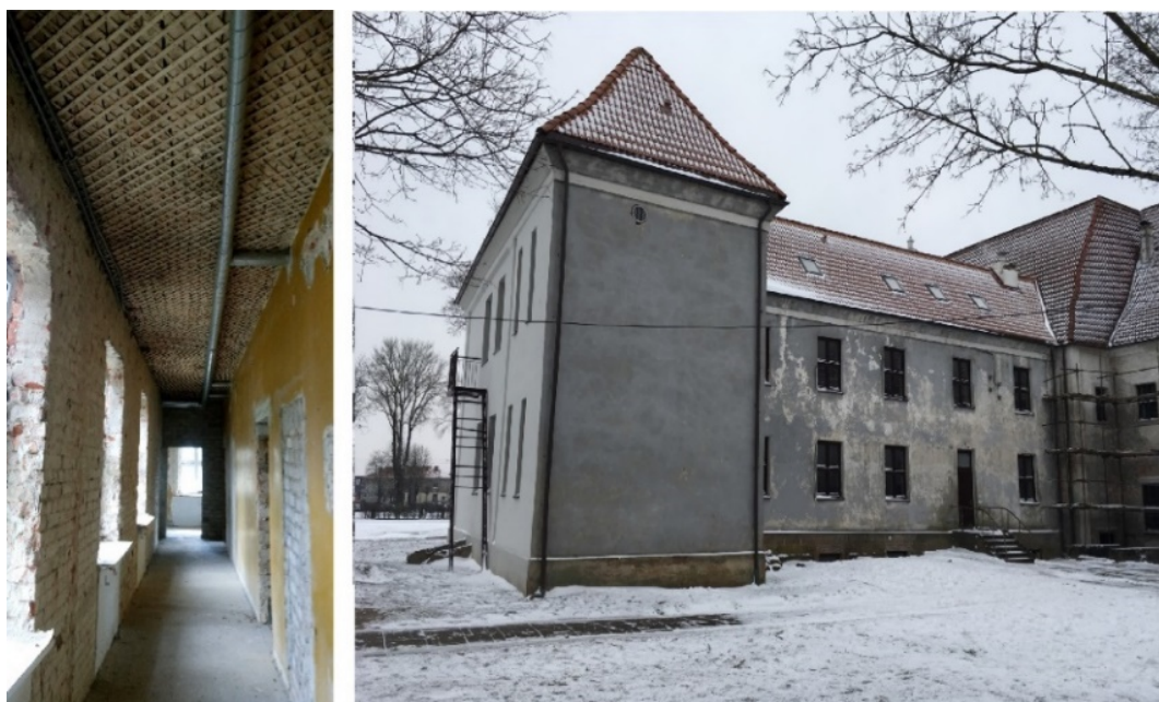
17 pav. Kretingos vienuolyno restauravimo ir atkūrimo darbai.
