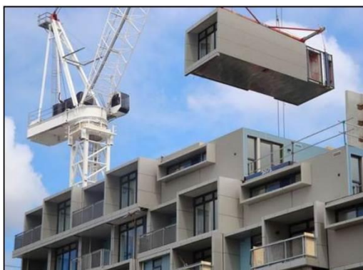
9 pav. Daugiaaukščio modulinio namo statyba bokštiniu kranu ( https://www.bca.gov.sg )
