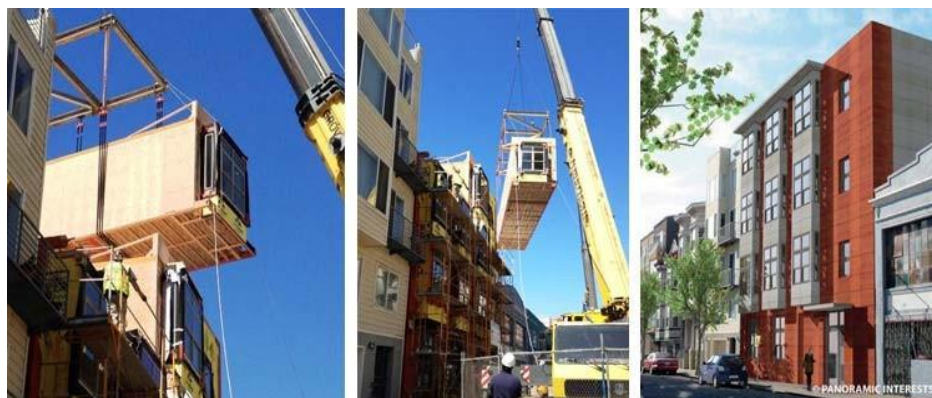
6 pav. 23 modulių daugiaaukščio gyvenamojo namo statyba (MBI, 2012)
