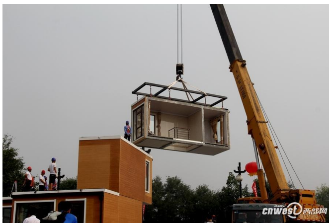
17 pav. Namų statyba iš modulių, atspausdintų 3D spausdintuvu ( https://3dprint.com )
