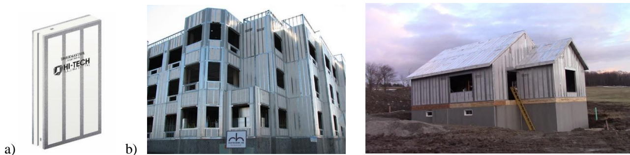
2.8 pav. a – „Thermosteel“ sienų plokštė [17]; b – namo sienos iš „Thermosteel“ sienų plokščių [17]
