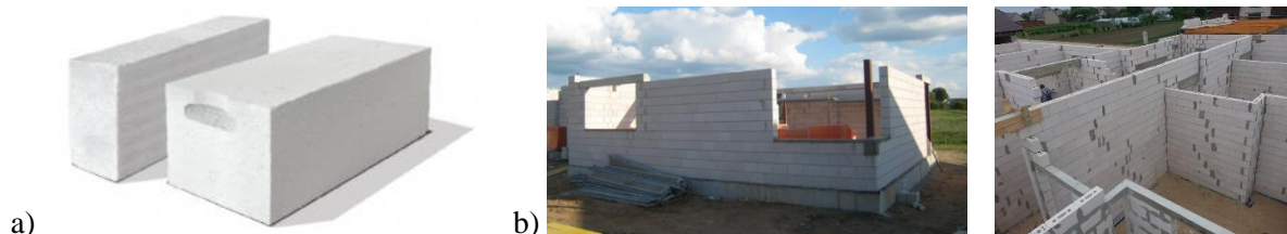
2.2 pav. a – dujų silikato blokeliai [11]; b – namo sienos iš dujų silikato blokelių [11]
