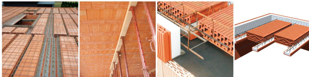
2.11 pav. „Heluz“ surenkama keraminių blokelių perdanga [20]
