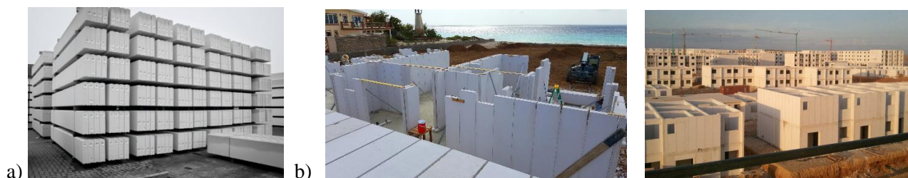
2.7 pav. a – dujų silikato moduliai [16]; b – namo sienos iš dujų silikato modulių [16]
