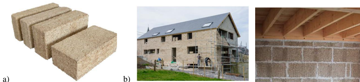
2.6 pav. a – kanapių blokeliai [15]; b – namų sienos iš kanapių blokelių [15]
