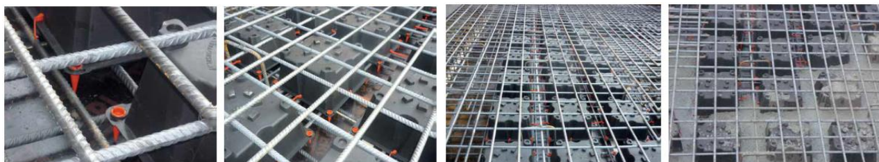
2.12 pav. Betonavimas panaudojant įdėklus [21]
