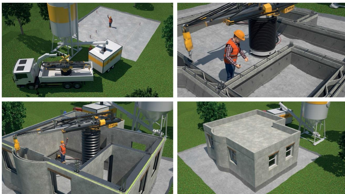
2 pav. 3D spausdinimo procesas statybų aikštelėje
