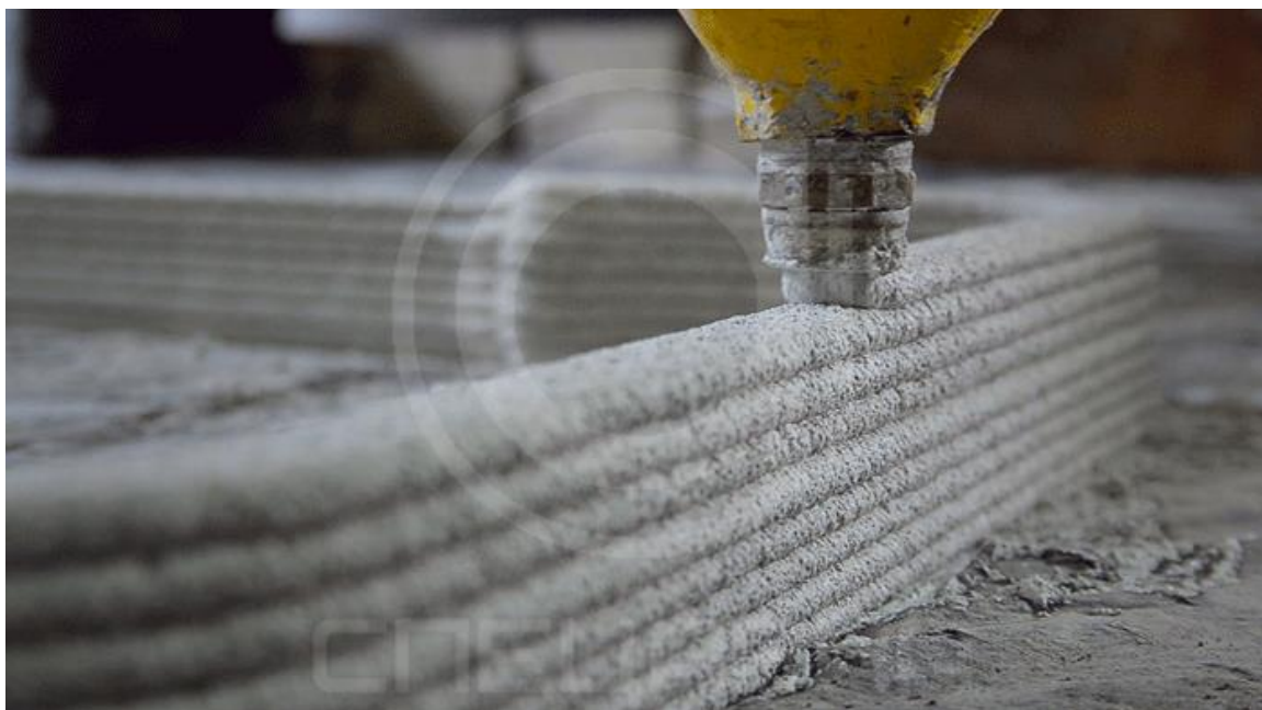
15 pav. 3D smėlio betono spausdinimas
