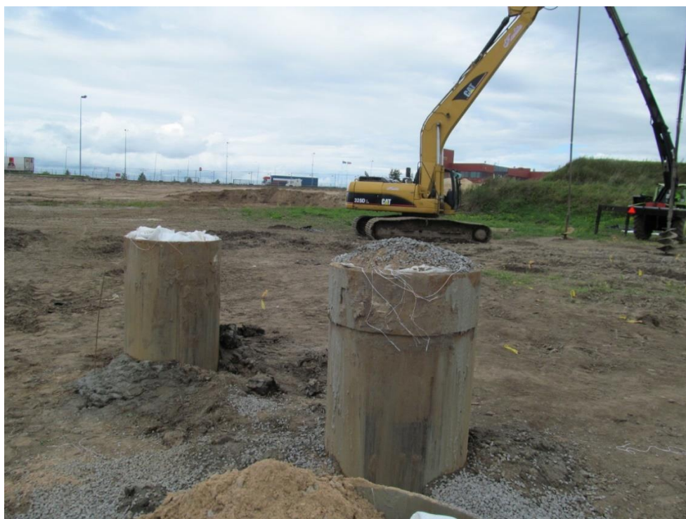
5.1.2 pav. Įrenginys skirtas užpildyti geotekstilės maišą (UAB „VIACON BALTIC“ nuotrauka)
