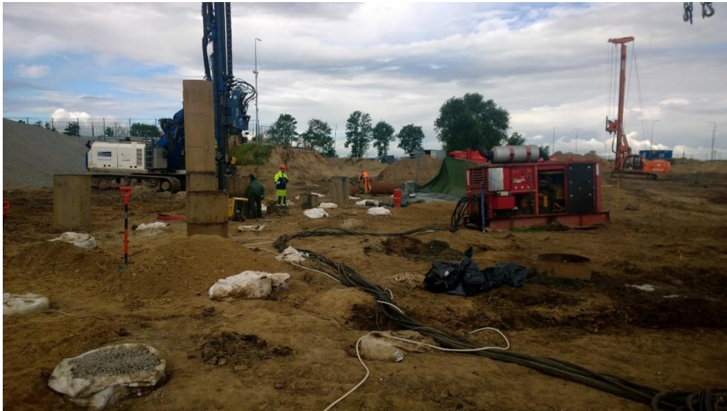
5.1.3 pav. Geopolijų įrengimas (UAB „VIACON BALTIC“ nuotrauka)
