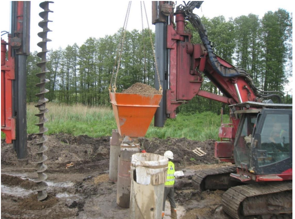
5.1.5 pav. Geopolių užpildymas gruntu (UAB „VIACON BALTIC“)
