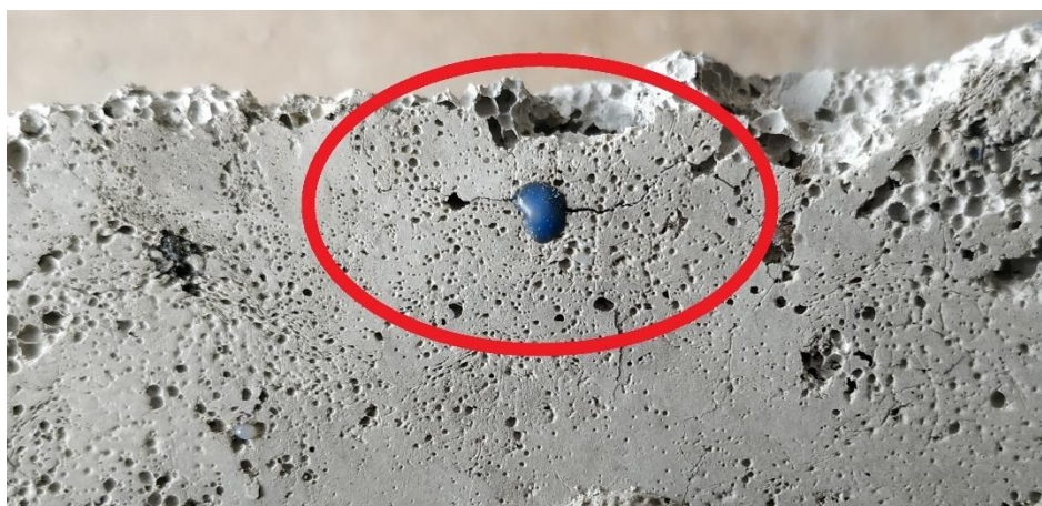
3.8.2 pav. Įtrūkimai ypač lengvo betono su plastiko granulėmis bandinyje
