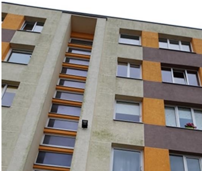
2.13 pav. Fasado apdailos sluoksnio pažeidimai
