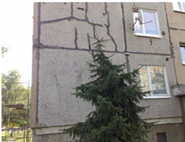
1.2 pav. Blokinio daugiabučio įtrūkusi siena
