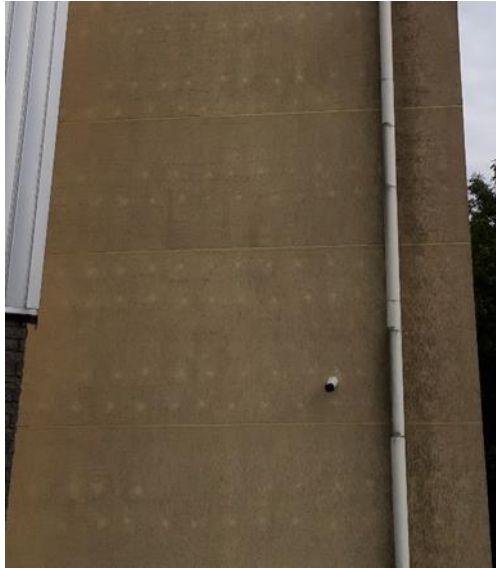
2.7 pav. Taškiniai šiluminiai tilteliai
