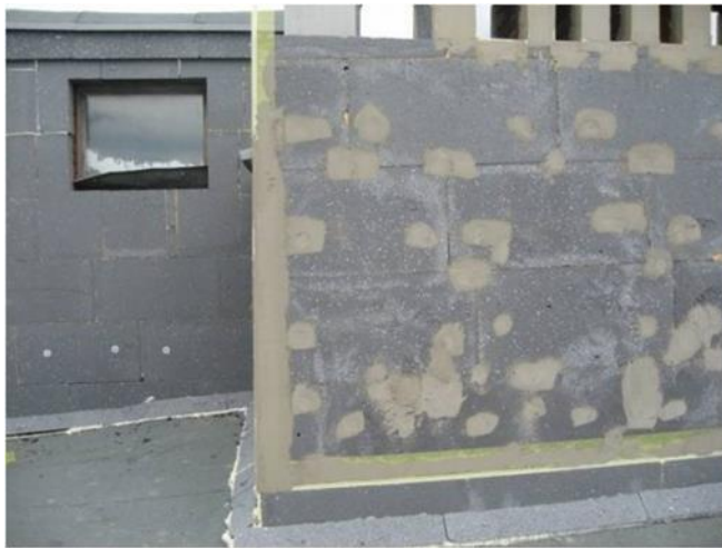
2.8 pav. Neteisingai pritvirtintos smeigės („BETA“ nuotrauka)
