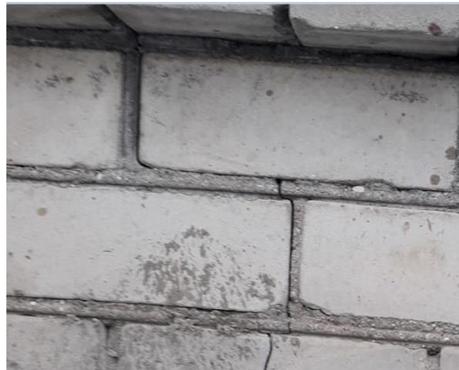
1.1 pav. Įtrūkusi mūro siena
