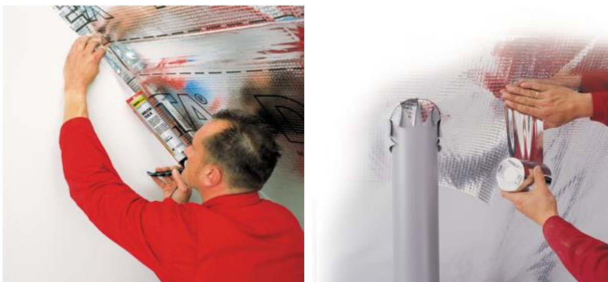
2.3 pav. Garams ir vėjui atsparias plėvelių sandarinimas [40]
