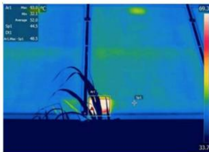
5 pav. Fotovoltinių panelių termovizinė nuotrauka [10]
