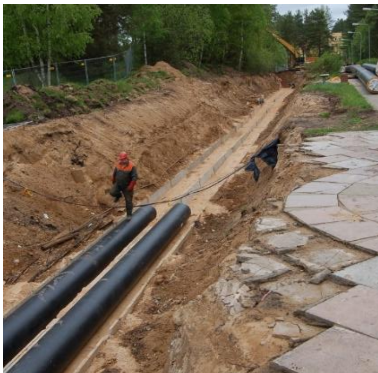
11 pav. Požeminiai bekanaliu būdu pakloti šilumos tiekimo vamzdynai
