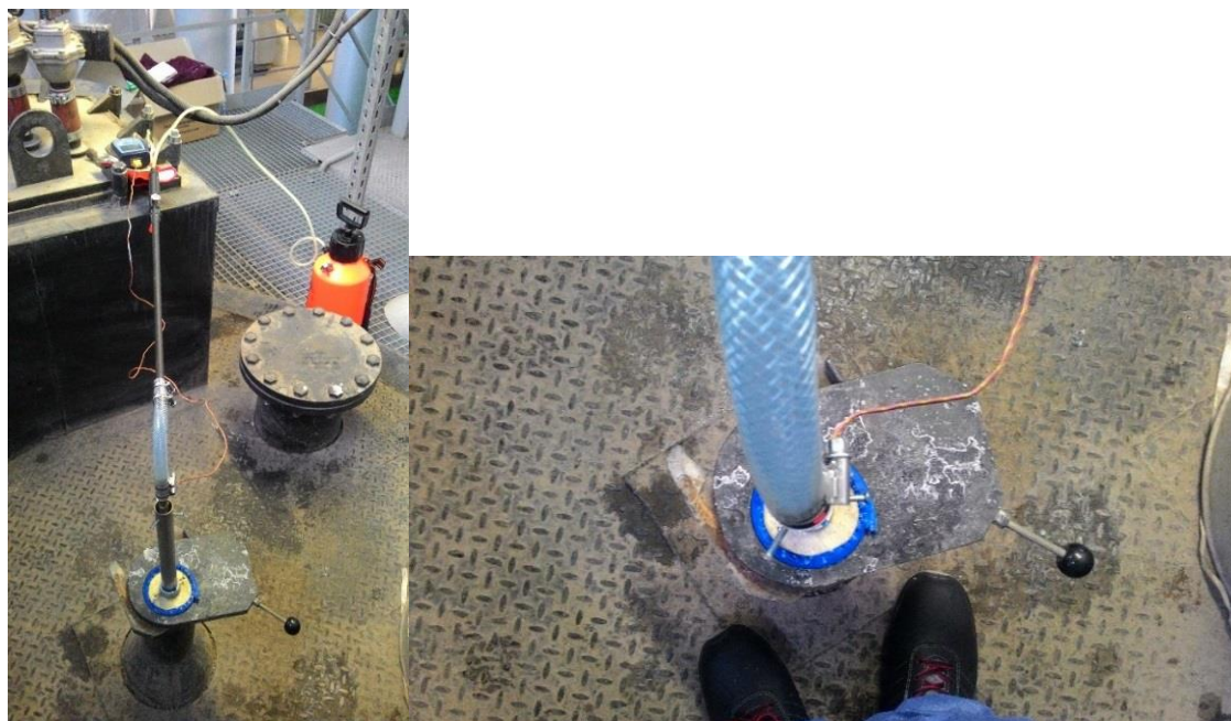
2.7 pav. Purkštuko, įstatyto į katilo kaitravamzdžio apžiūros atvamzdį, vaizdas.
