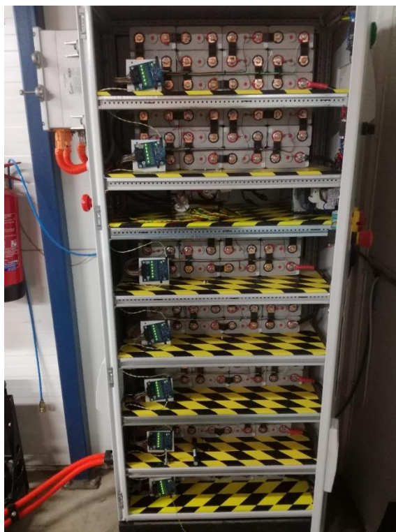
3.2 pav. Baterijų spinta.
