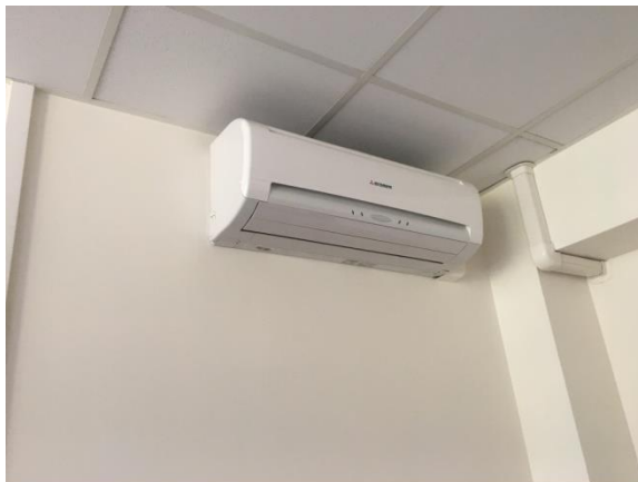
3.3 pav. Tiriamojo objekto patalpų oro šaldymui naudojamas kondicionierius.
