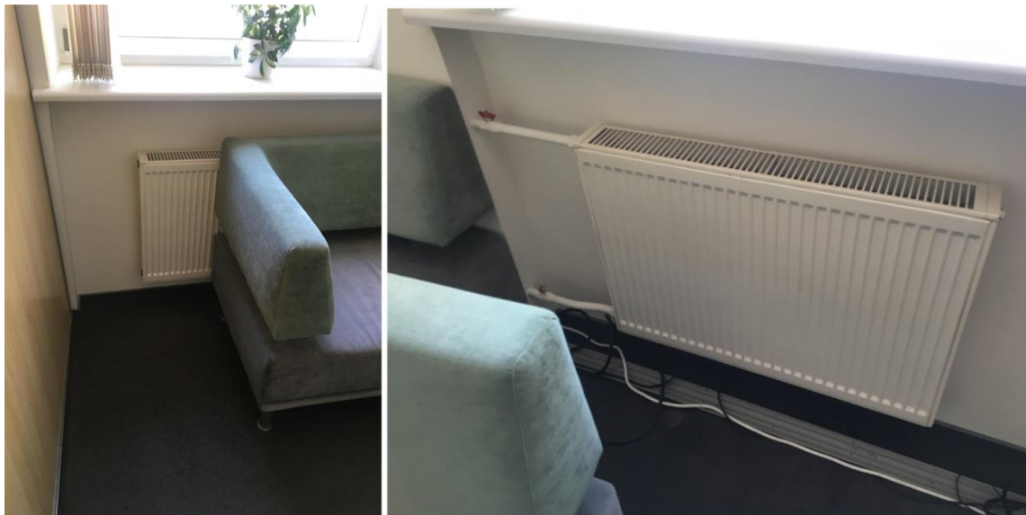
3.1 pav. Tiriomojo objekto šildymo sistemos radiatoriai.
