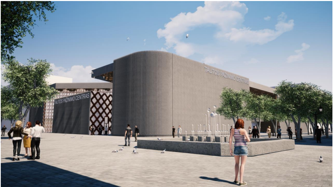
104 pav. Tautos pažinimo centro pagrindinis fasadas nuo Kauno Laisvės al. Pastato eksterjeras „šiuruliškai tuščias“, vidinė pastato erdvė savo raiška kviečianti pažinti.
