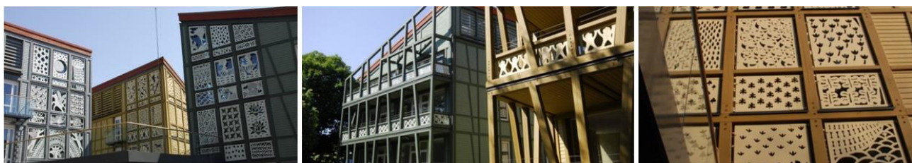
74 pav. Vila „Jūra. Smėlis. Vėjas.“ Miško g.1 Juodkrantėje, architektai: Gintaras Prikockis, Asta Prikockienė, Inga Tikuišytė, Andrius Velutis; statybos metai: 2008 (nuotrauka G. Prikockis, A. Velučio) (Štelbienė (n.d.))
