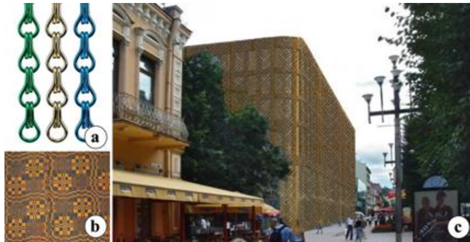
Variantas Nr. 2. Skambantis fasadas. Projektuojamo fasado dekorumui pabrėžti naudojama metalo segmentų užuolaidos, kuri vėjui papūtus suskamba tarytum daina. a - „Kriskadecor” metalinis elementas (nuotrauka iš Kriskadecor.com); b – tautinis taudinys (Audinio nuotrauka iš Atspindys Australija n.d.) c - pastatas
