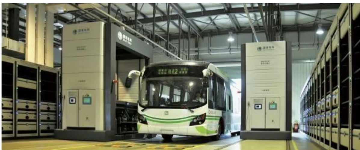
7. pav. Elektrinių autobusų išmanaus krovimo, baterijų keitimo ir saugojimo stotis Kinijoje [16]
