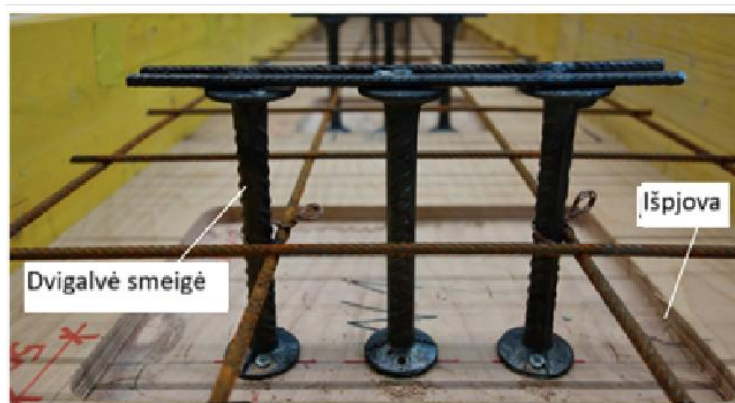
4 pav. LVL išpjovimas jungčiai su strypinėmis jungtimis
