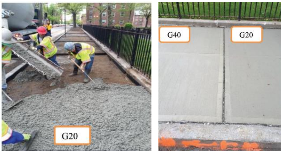
19 pav. Šaligatvio įrengimas naudojant G20 ir G40 betono mišinio sudėtis [42]
