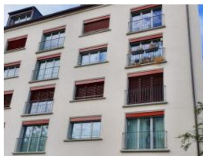
11 pav. Kairėje: superizoliaciniai tinkai, užtepti purkštuvu pagalba ant demonstracinės sienos. Dešinėje: superizoliaciniai tinkai, užtepti ant gyvenamojo namo išorinės sienos Ciuriche, Šveicarijoje [38 p.2]
