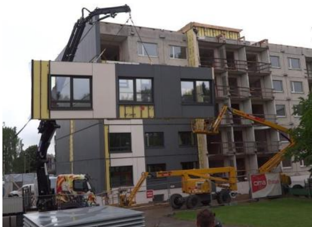
9 pav. Surenkamojo ventiliuojamo fasado elemento montavimas [32 p. 4]
