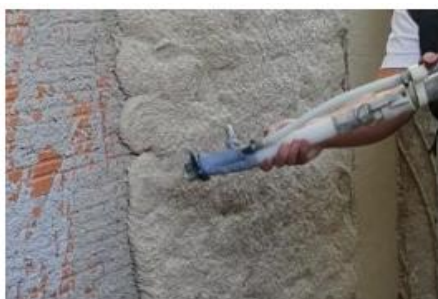
11 pav. Kairėje: superizoliaciniai tinkai, užtepti purkštuvu pagalba ant demonstracinės sienos. Dešinėje: superizoliaciniai tinkai, užtepti ant gyvenamojo namo išorinės sienos Ciuriche, Šveicarijoje [38 p.2]
