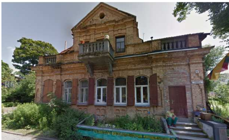
5 pav. Objektas prieš vykdant darbus
