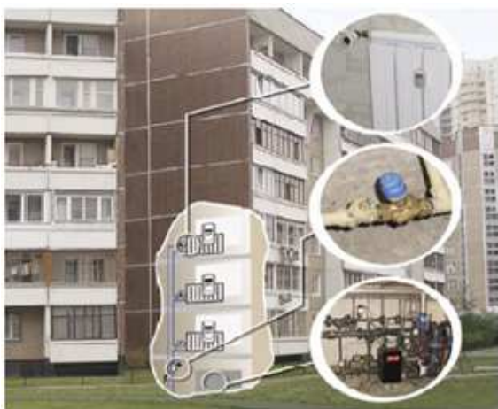
21. pav Vienvamzdės sistemos renovacija
