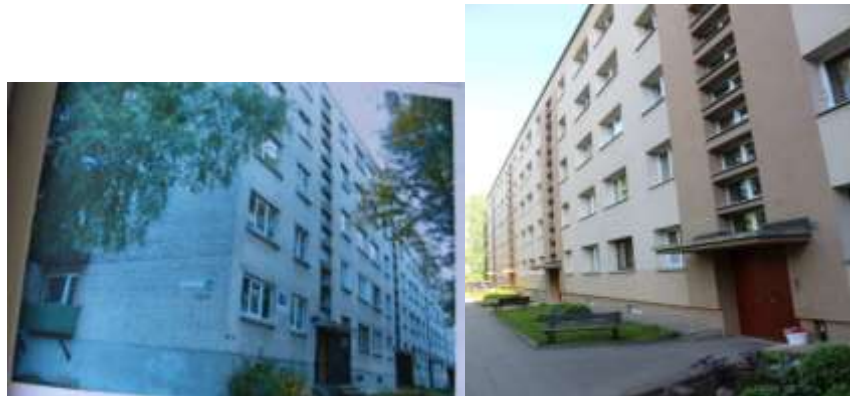
4 pav. Daugiabutis namas Alytuje prieš ir po išorinių atitvarų renovacijos.
