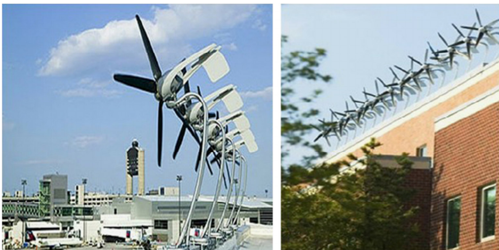
1 pav. Mažų vėjo jėgainių įrengimo ant pastato stogo fragmentas [12]
