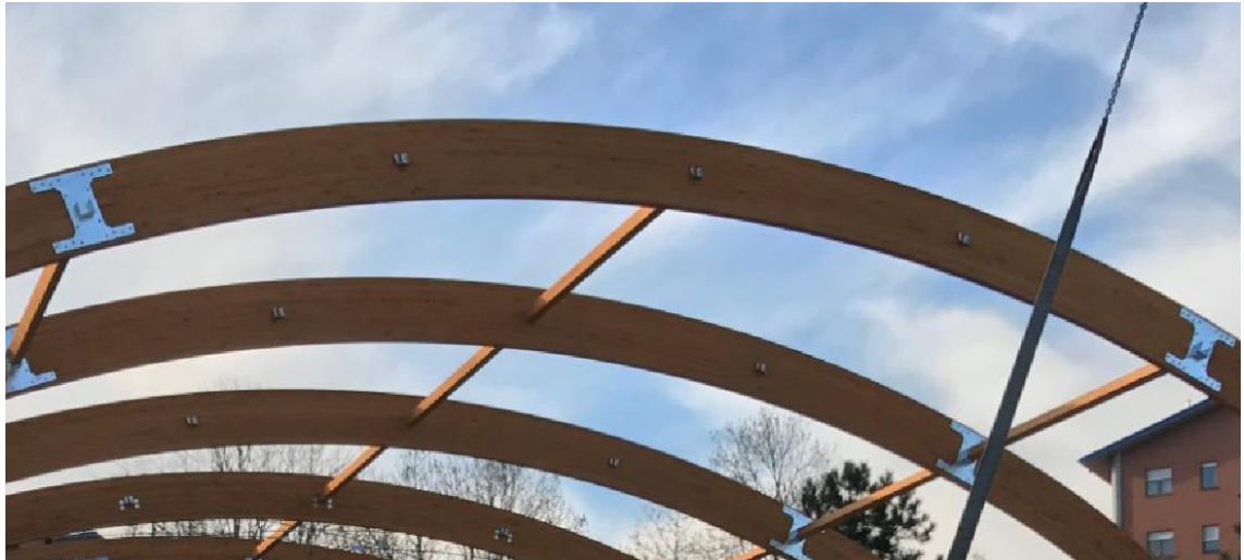
7.4.1 pav. Ryšių sijos, pritvirtintos centre klijuotos medienos arkos
