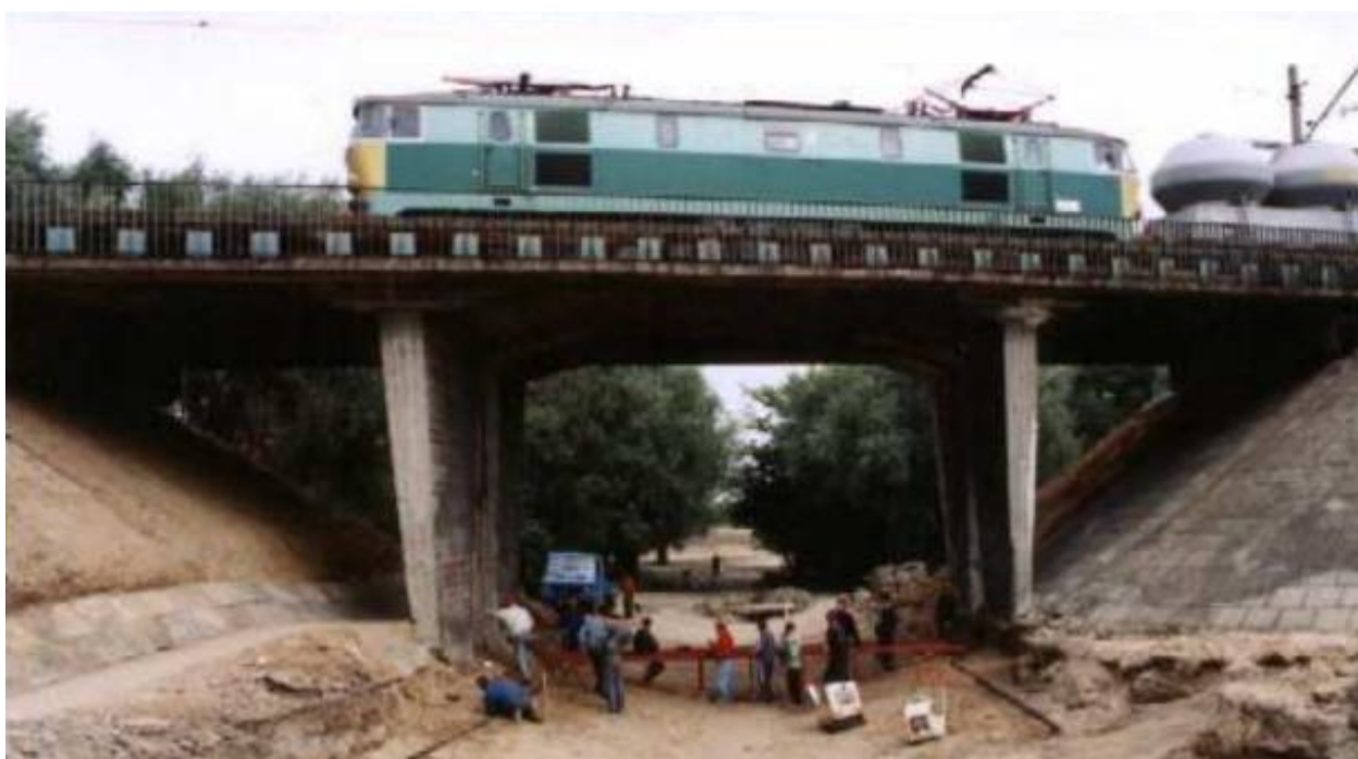
14 pav. Pralaidos pagrindų ruošimas po esamu viaduku [27]
