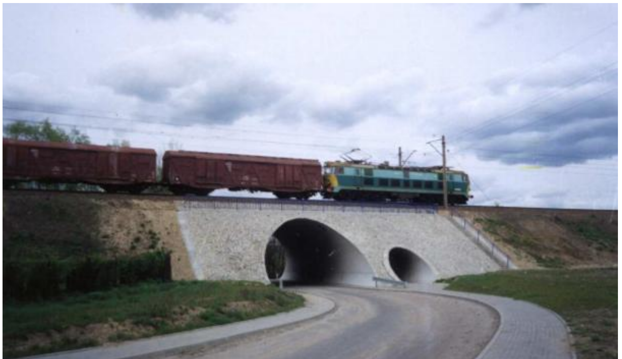
16 pav. Sumontuotos pralaidos bei paleistas traukinių eismas [27]
