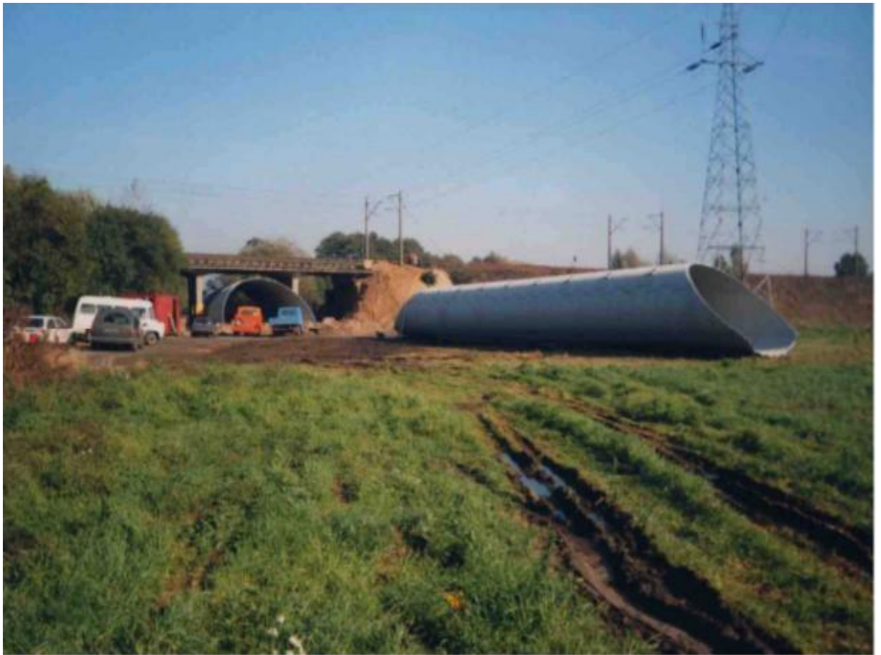
15 pav. Pralaidų surinkimas bei pastatymas į projektinę padėtį [27]
