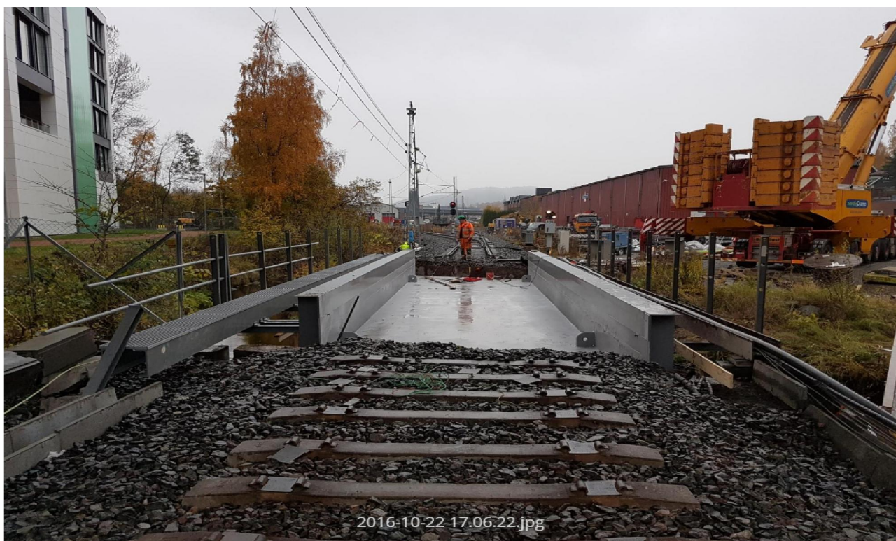
12 pav. Tilto per Semselvo upę rekonstrukcija
