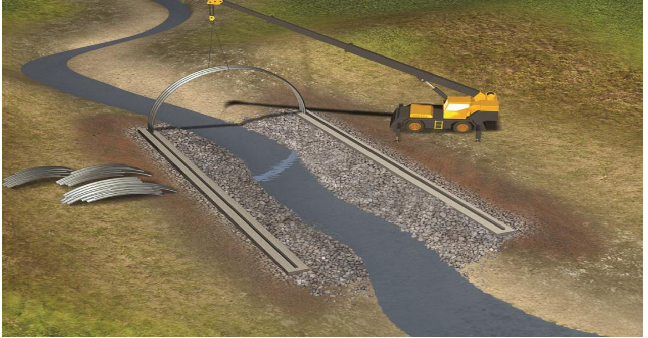
33 pav. Gofros lakštų surinkimas ant žemės
