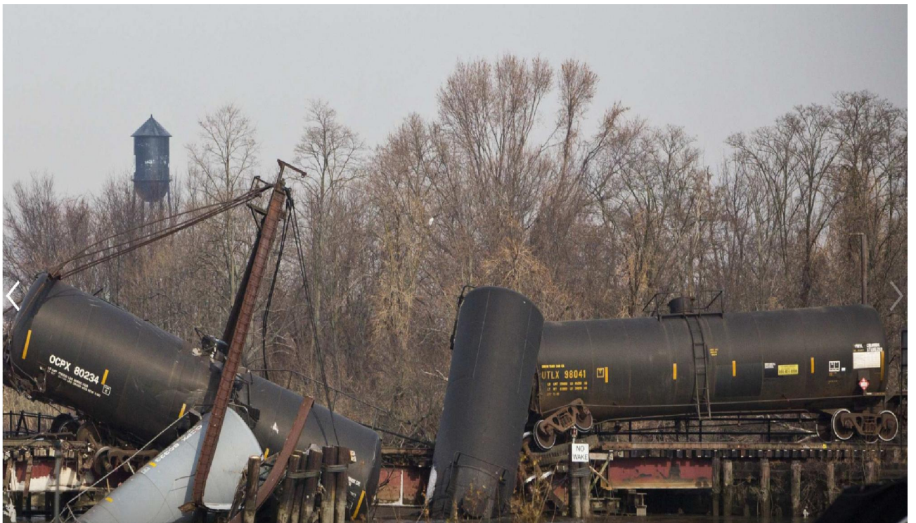
10 pav. Sugriuvęs plieninis geležinkelio tiltas Naujajame Džersyje, JAV [24]
