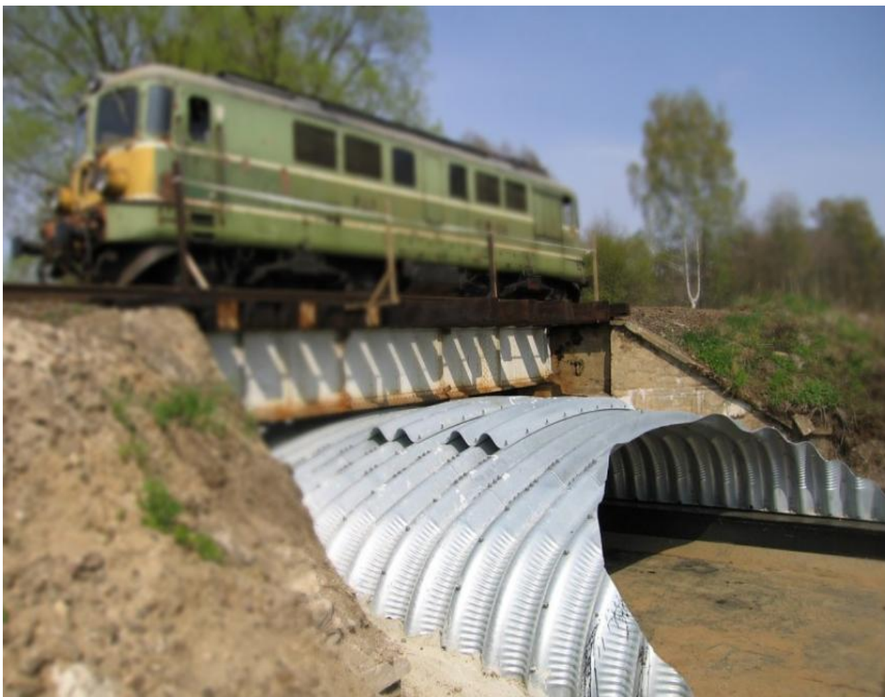
5 pav. Pralaidos panaudojimas rekonstruojant nedidelius tiltus [22]
