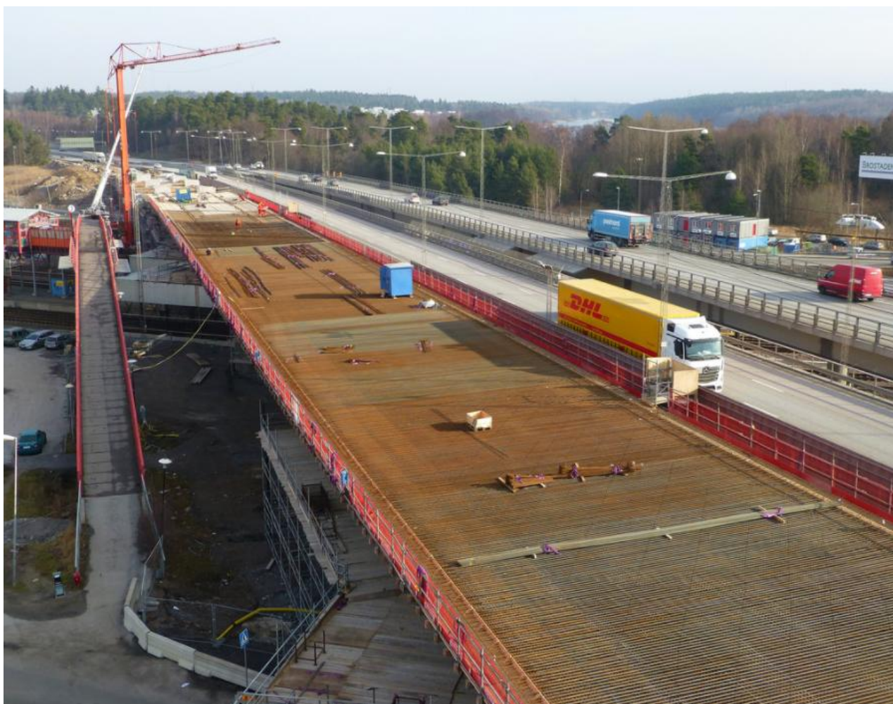
17 pav. Rotebro tilto rekonstrukcija
