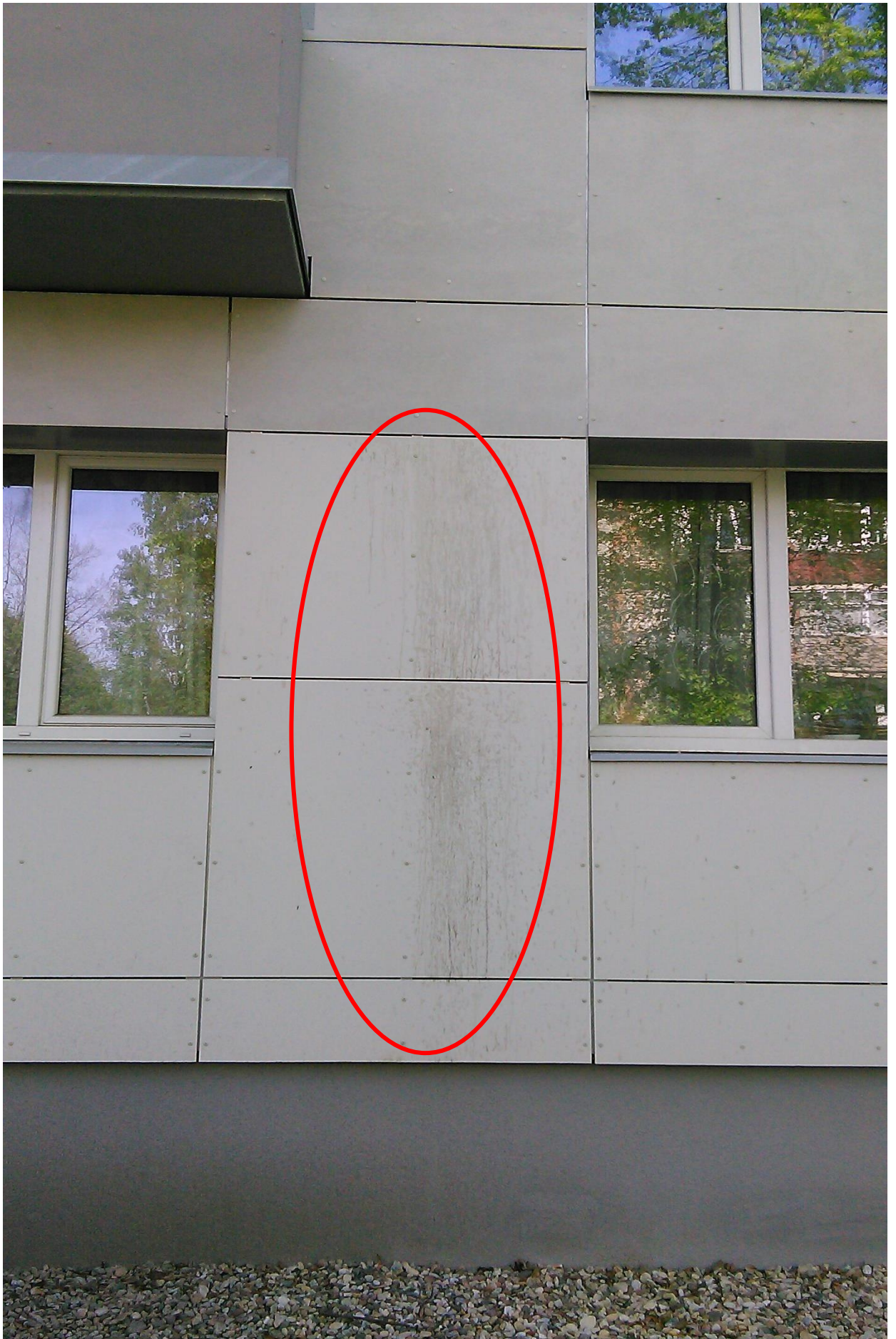
1.23. pav. Plokščių išpurvinimas.
