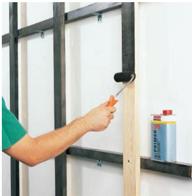
2.3. pav. Medinis laikantysis karkasas [22].
