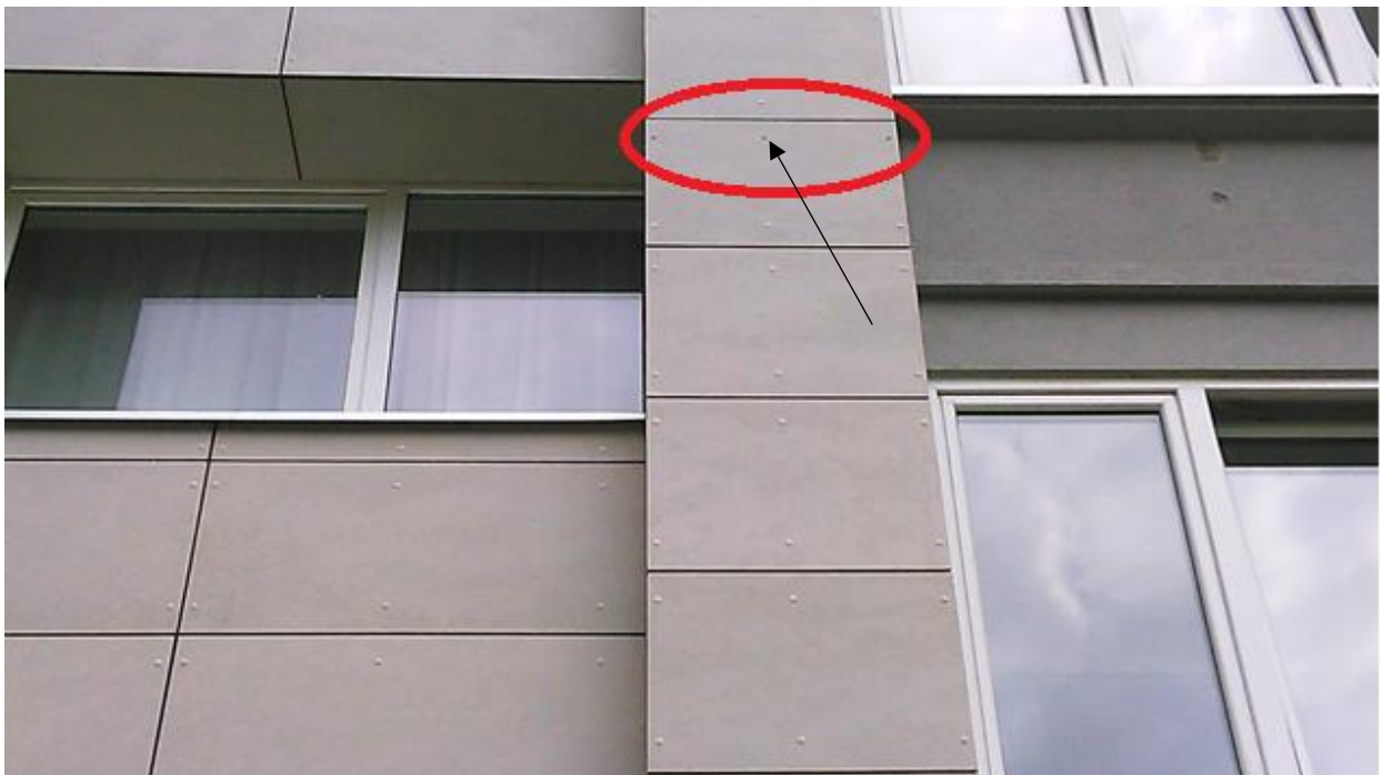
1.29. pav. Darbininkų paliktos skylės be kniedžių.
