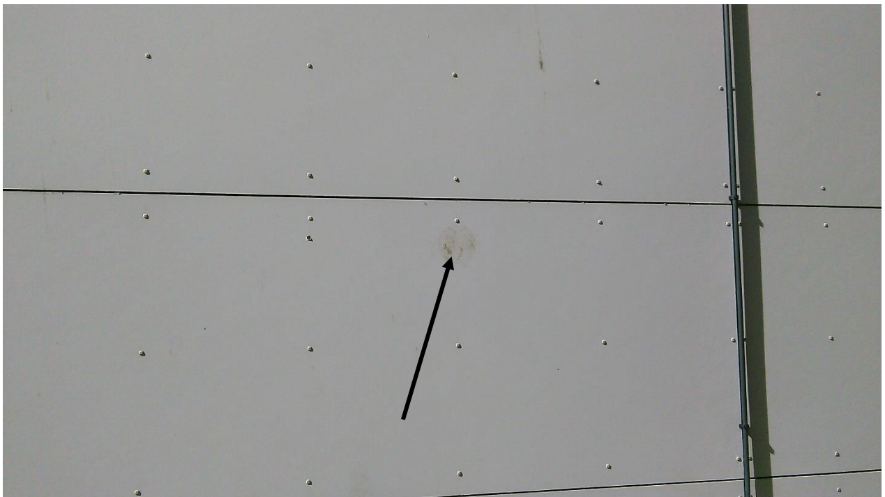
1.25. pav. Plokščių išpurvinimas ir darbininkų palikta papildoma skylė kniedei.
