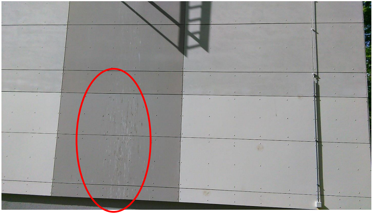
1.24. pav. Plokščių išpurvinimas.
