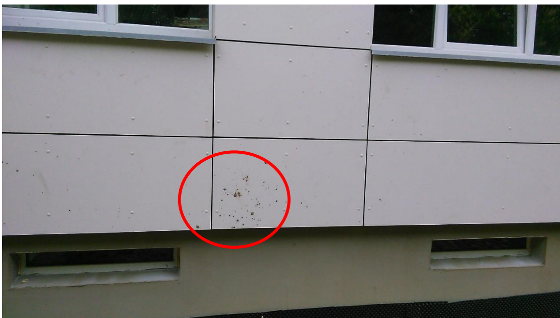
1.22. pav. Plokščių išpurvinimas.
