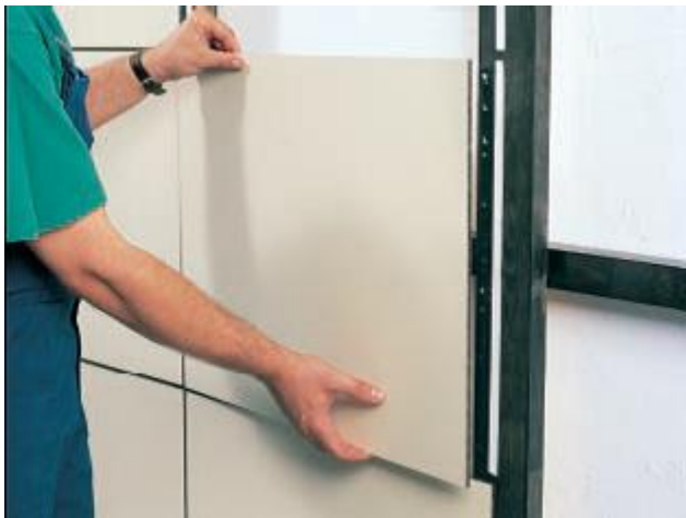
2.8. pav. Plokščių klijavimas prie karkaso [22].
