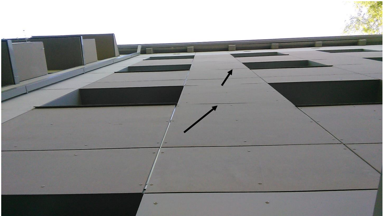
1.26. pav. Blogai įrengtas plokščiu laikantysis karkasas.
