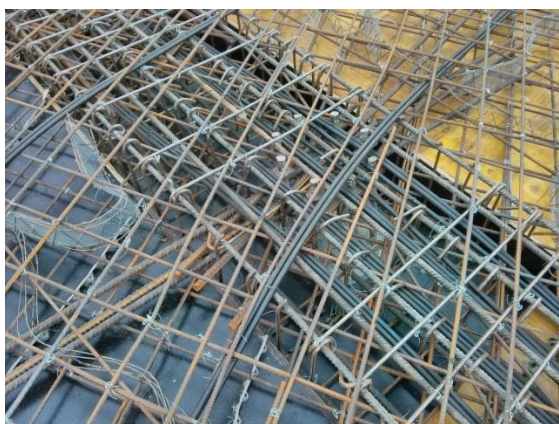
27 pav. Betono mišinio tekėjimą ant nuožulnios plokštumos stabdančių ribotuvų panaudojimas, administracinio pastato Vilniuje, Konstitucijos pr. 29 nuožulnios perdangos įrengimui
