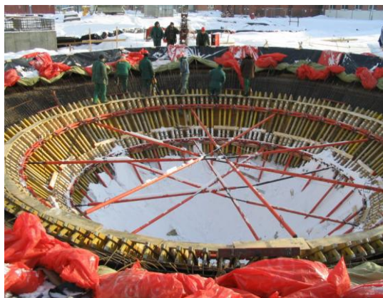
Dumblo pūdytuvo dugno betonavimo vaizdas
