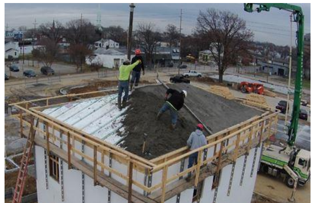
8 pav. Šlaitinio stogo betonavimo procesas [3]
