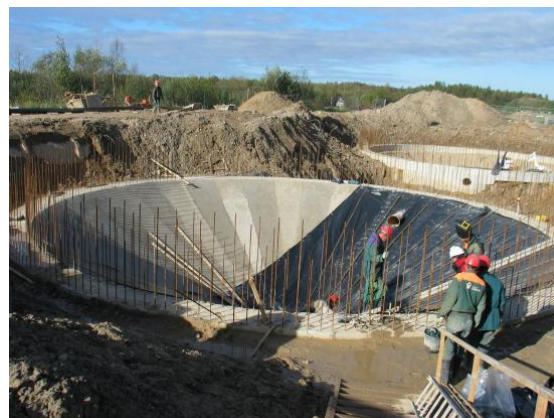
Išbetonuoto dumblo pūdytuvo dugno dengimas polietileno plėvele
