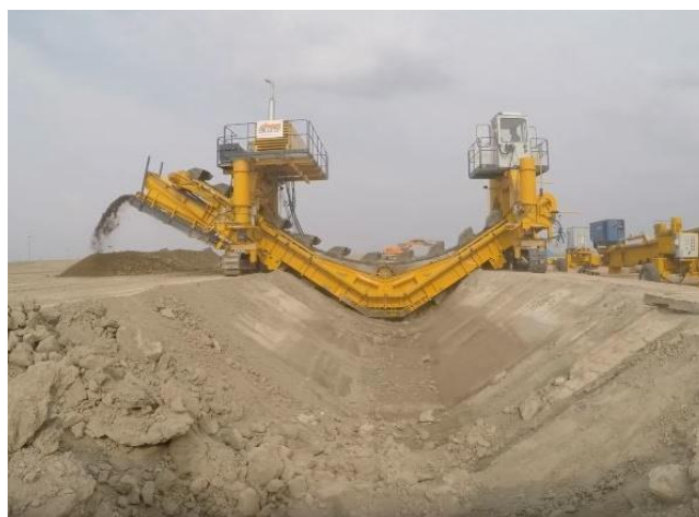
5 pav. Kanalo kasimo vaizdas [2]
