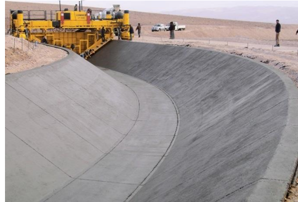
6 pav. Kanalo dugno ir šlaitų betonavimas, naudojant GOMACO specialiąją techniką [2]
