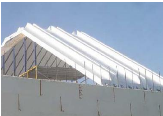
7 pav. Surenkamojo gelžbetonio šlaitinės konstrukcijos, kurios vėliau bus užmonolitinamos [3]
