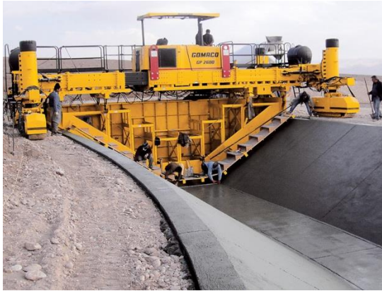
6 pav. Kanalo dugno ir šlaitų betonavimas, naudojant GOMACO specialiąją techniką [2]
