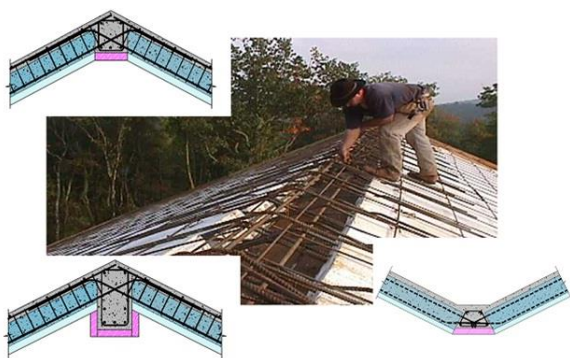
9 pav. Šlaitinio stogo armavimo procesas [3]
