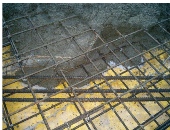
27 pav. Betono mišinio tekėjimą ant nuožulnios plokštumos stabdančių ribotuvų panaudojimas, administracinio pastato Vilniuje, Konstitucijos pr. 29 nuožulnios perdangos įrengimui
