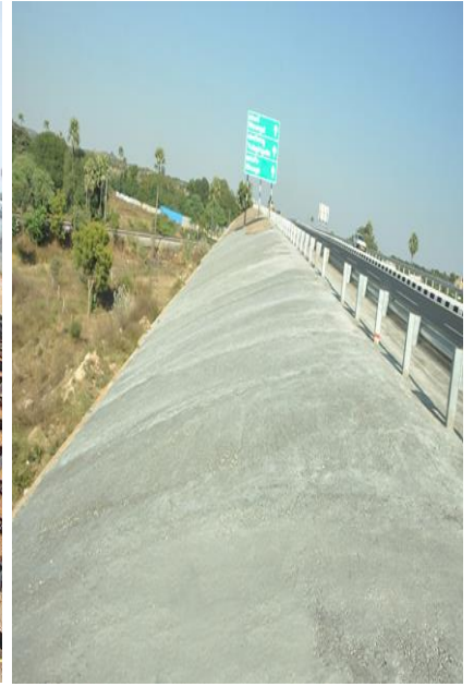
Išbetonuotas šlaitas
