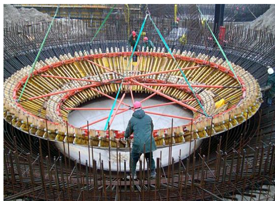
Peri GVR klojinių skydų montavimas dumblo pūdytuvo dugno betonavimui
