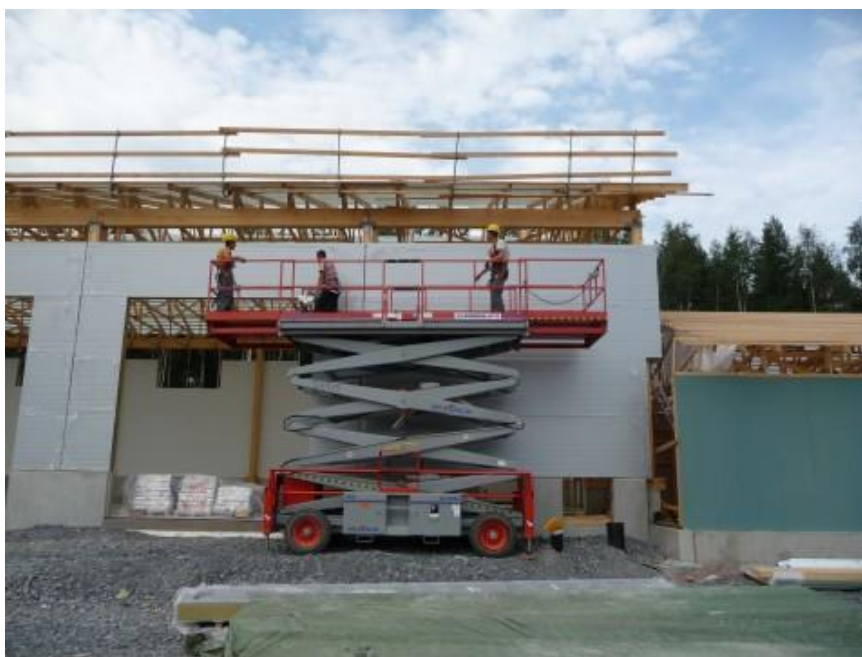
8 pav. Daugiasluoksnių plokščių montavimas(4)
