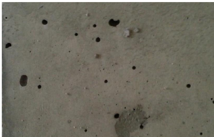
6.1.1.1. pav. Monolitinio betono paviršiuje susidariusios poros (autorius nuotrauka)
