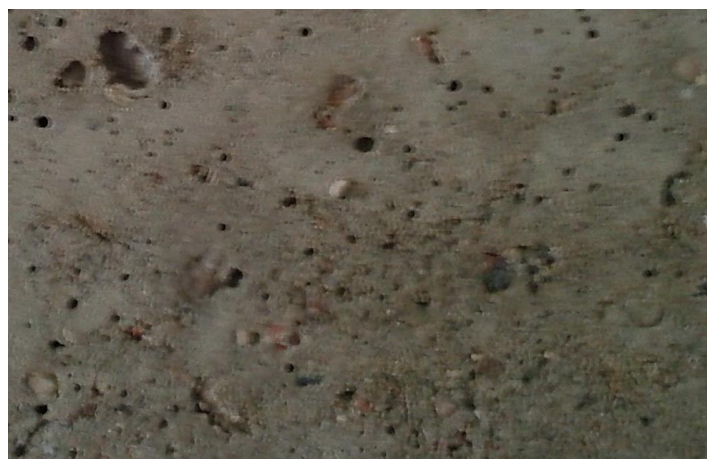
6.1.1.3. pav. Susiformavęs korėjimas monolitinio betono paviršiuje (autoriaus nuotrauka)
